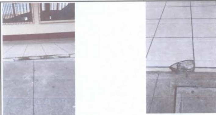
foto No. 17 y 18 reparación de piso ceramico
