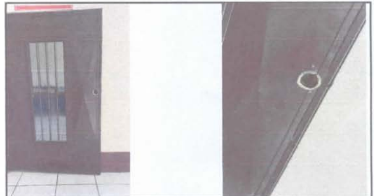
foto No. 19 sutitución de chapa de puertas de metal.
