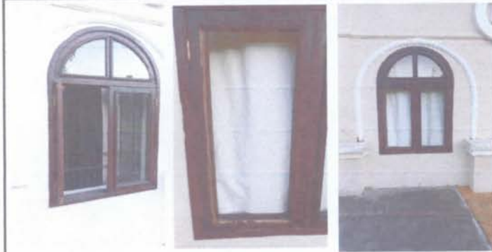
FOTO No. 12 y 13 sustitución de 2 vidrios
