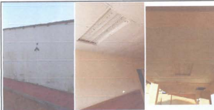
foto 21 y 22 reparación de sistema eléctrico sustitución de lamparas de 2x 20
