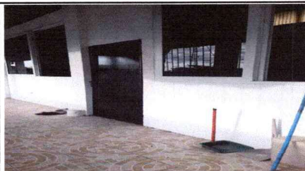
Pintura de aulas exterior
