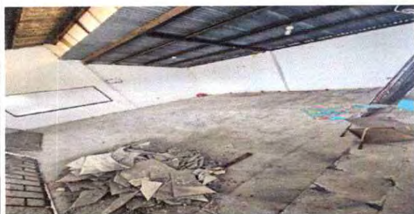
Cambio de piso cerámico
