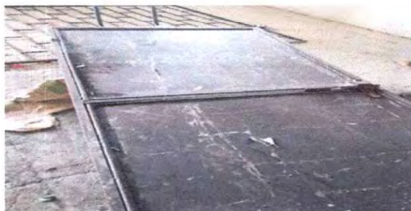
Reparación de puertas
