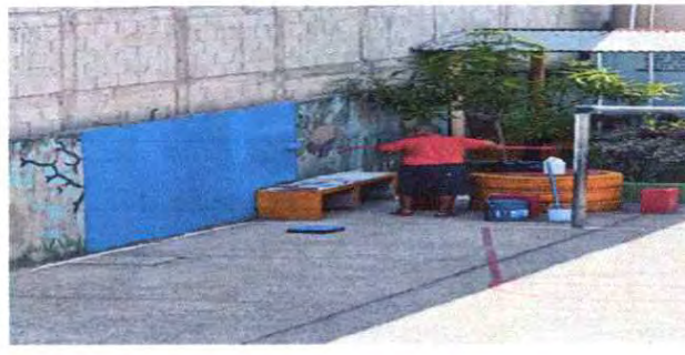
Primer Retoque del muro perimetral
