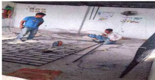
Reparación de Balcones
