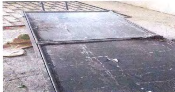
Reparación de puertas lijado y pintura
