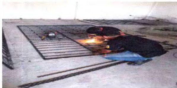
Reparación y reconstrucción de balcones
