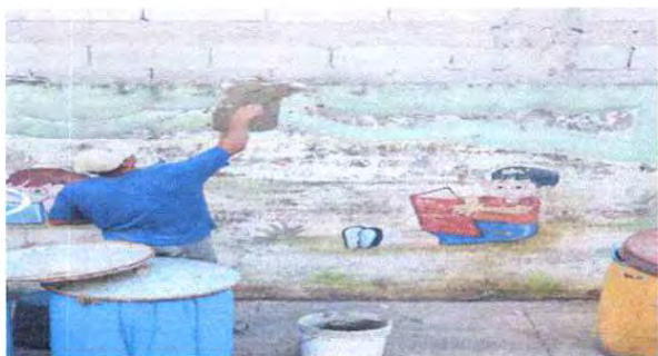
Limpieza y sellado en el muro perimetral
