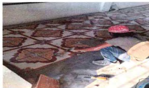
Colocación de piso cerámico
