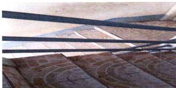
Lijado y pintura de tubos de baranda.
