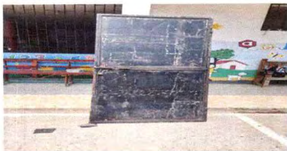
Reparación de puertas
