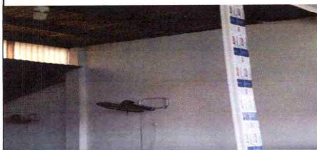
Medición de ventanas
