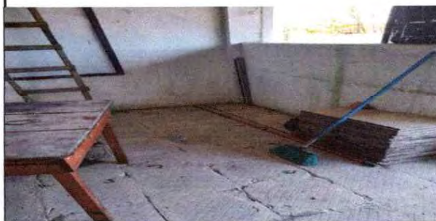
Reparación de piso cerámico
