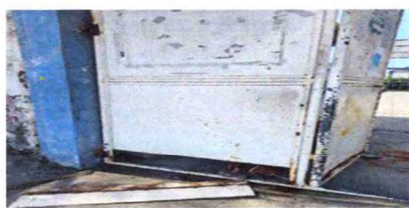
Reparación del portón.
