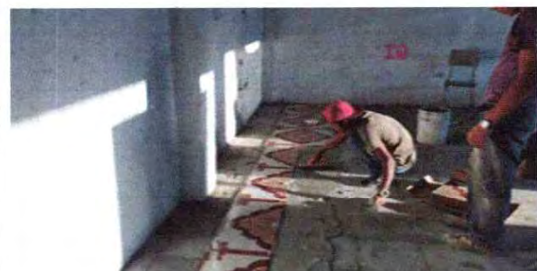
Colocación de piso cerámico
