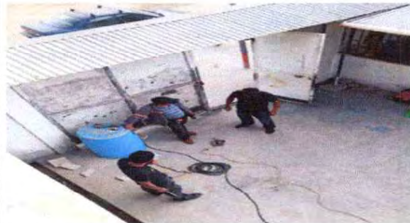
Preparando el material para reparación del portón
