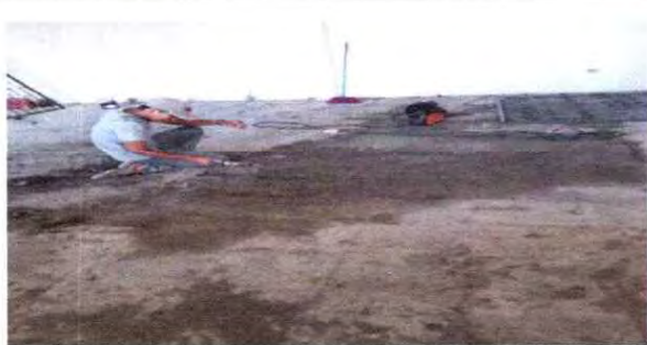
Preparación para la colocación de piso cerámico
