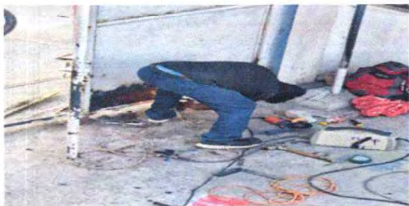
Reparación del portón.
