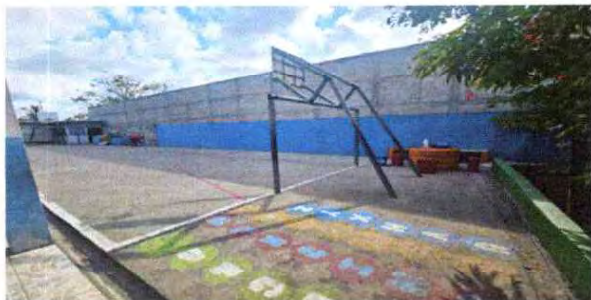
Retoque del muro perimetral
