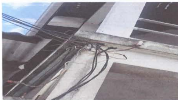
6- Instalación de tablero y flipones
