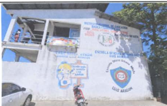
5- Pintura en muros e interiores (aulas 260mts. Y muro perimetral 70mts)
