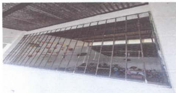
2-Mantenimiento a balcones de metal
