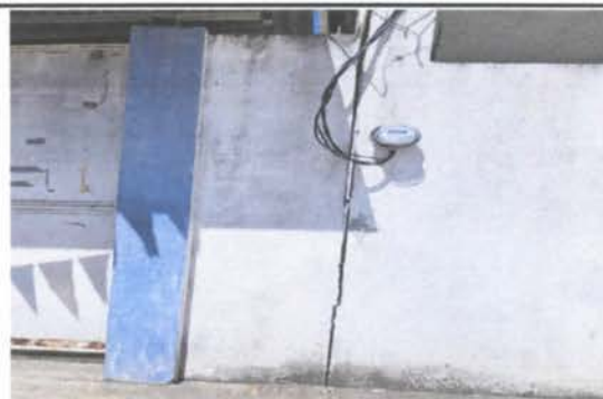
5- Pintura en muros e interiores (aulas 260mts. Y muro perimetral 70mts)
