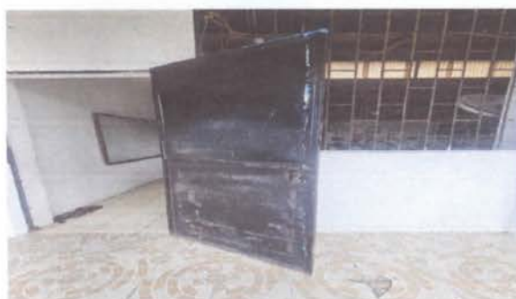
5-Mantenimiento a estructura de puertas (lijado, cambio de tubo, cepillado, sujeciones, aplicación de pintura)
