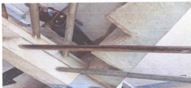
1-Mantenimiento a estructura de puertas (lijado, cambio de tubo, cepillado, sujeciones, aplicación de pintura)
