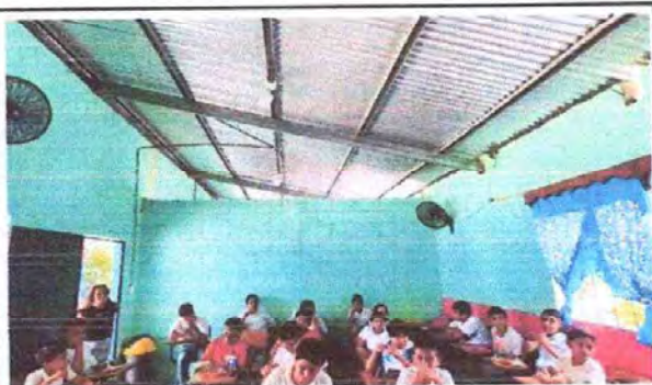
Foto 9: Suministro y aplicación de pintura
