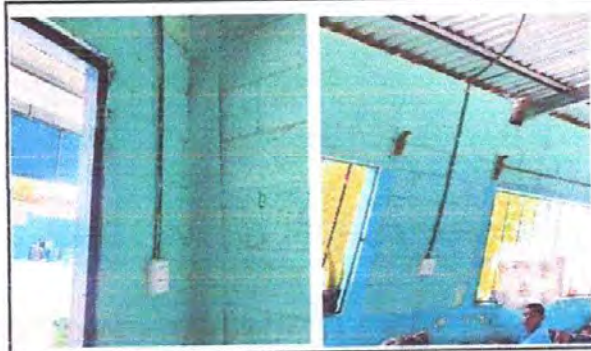
Foto 10: Suministro y colocación de sistema eléctrico
