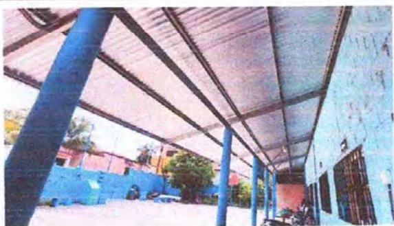
Foto 7: Suministro e instalación de estructura portante metálica y lamina troquelada calibre 26
