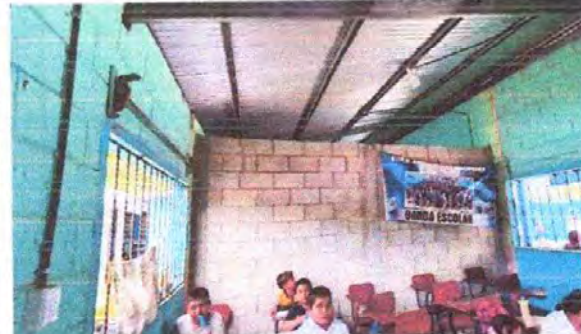
Foto 8: Suministro y levantado de muro de block
