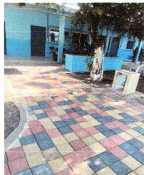
Foto 2: Instalación de adoquín
