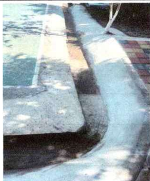
Foto 3: Fabricación de cuneta
