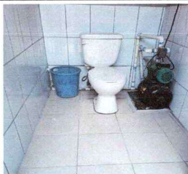
Foto 5: Instalación de piso, más azulejo
