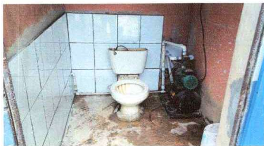
Foto 5: Instalación de azulejo
