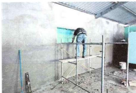
Foto 1: Impermeabilización de pared
