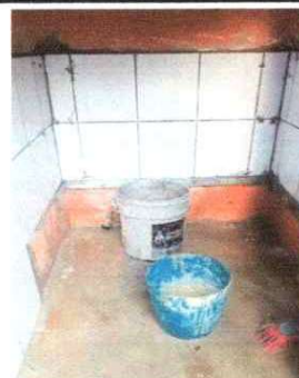
Foto 6: Instalación de azulejo
