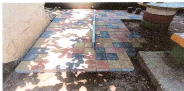
Foto 4: Instalación de adoquín
