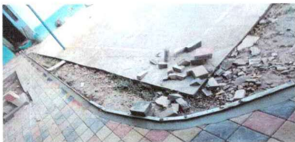
Foto 3: Preparación de cuneta
