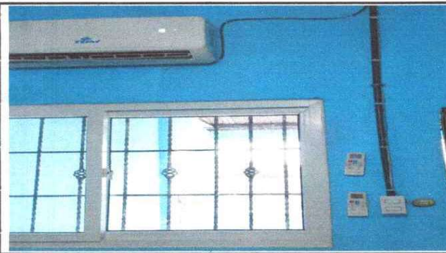
Foto 3: INSTALACION DE UNIDADES Y CABLE ELECTRICO
