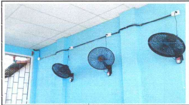
Foto 4: INSTALACION DE UNIDADES DE FUERZA (TOMACORRIENTES)
