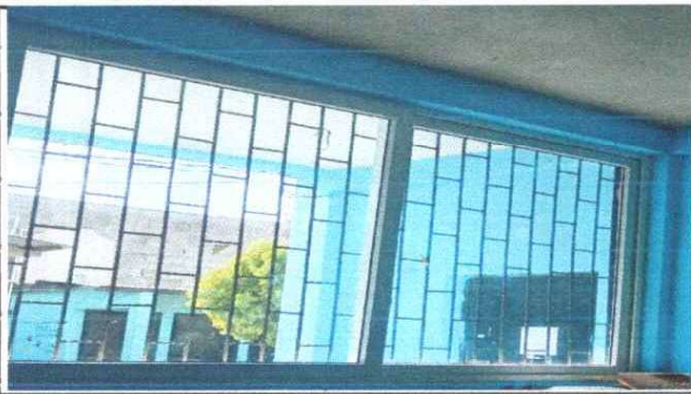
Foto 1: SUSTITUCION DE VENTANAS DE MADERA A VIDRIO
