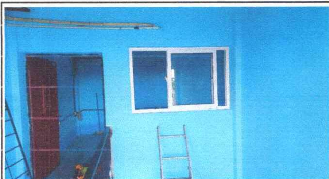
Foto 1: SUSTITUCION DE VENTANAS DE MADERA A VIDRIO
