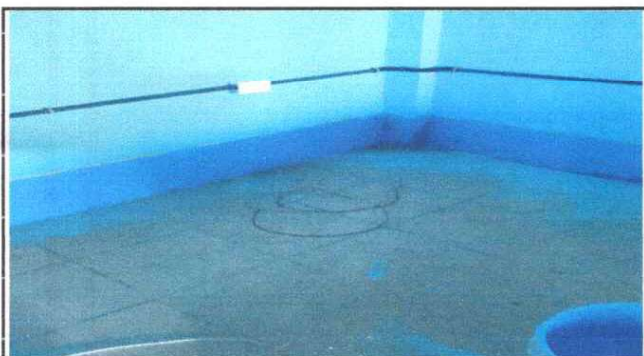
Foto 3: INSTALACION DE UNIDADES Y CABLE ELECTRICO
