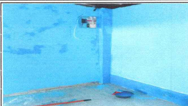
Foto 2: REPARACION DE CABLEADO ELECTRICO
