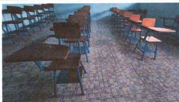
Foto 3: Suministro e instalación de piso cerámico antideslizante
