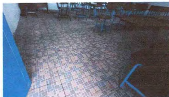
Foto 4: Suministro e instalación de piso cerámico antideslizante
