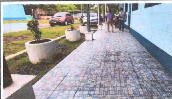
Foto2: Suministro e instalación de piso cerámico antideslizante
