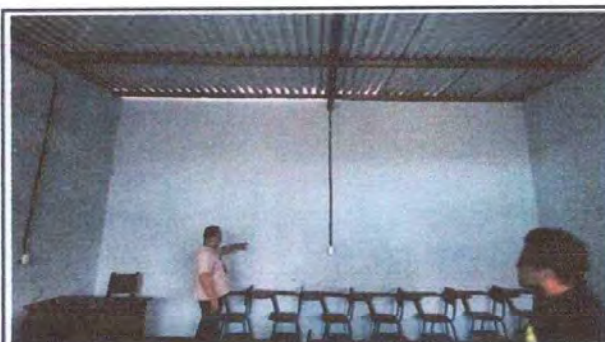
Foto 10: Instalación de alambrado eléctrico en aulas
