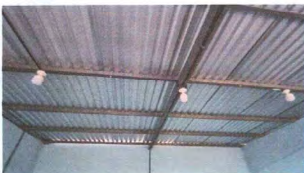
Foto 9: Instalación de Bombillas y tomacorrientes
