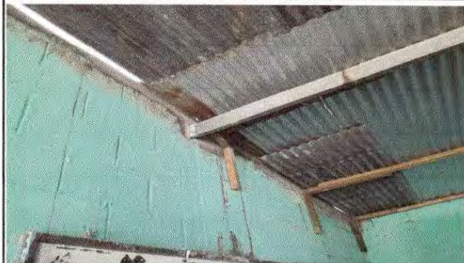
Foto 10 REMOZAMIENTO DE TECHO, SUMINISTRO E INSTALACION DE LAMINA TROQUELADA CAL 26
