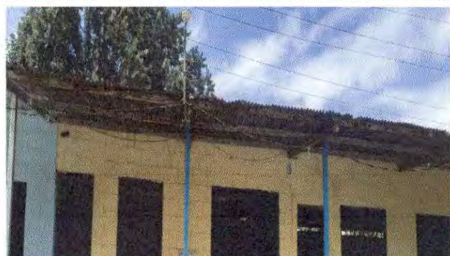
Foto 3: MODULO "A" AULAS REMOZAMIENTO TECHO ESTRUCTURA
