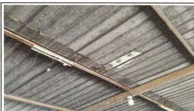
Foto 6: MODULO "A" AULAS SUMINISTRO E INSTALACION DE LAMINA TROQUELADA CAL 26
