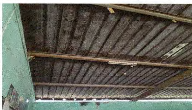
Foto 8 SUMINISTRO E INSTALACION DE LAMINA TROQUELADA CAL 26
