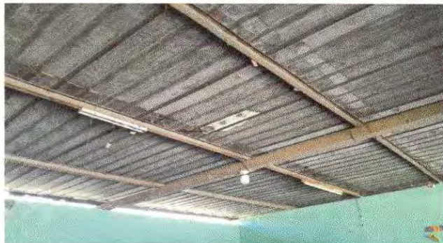
Foto7: SUMINSITRO E INSTALACION DE ESTRUCTURA METALICA
