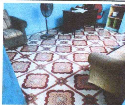
Foto 10: Suministro e instalación de piso cerámico antideslizante
