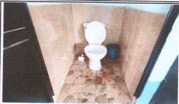
Foto 7: Suministro e instalación de piso cerámico antideslizante, azulejo e inodoro.
