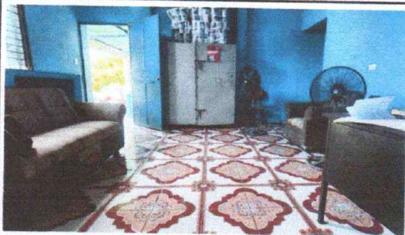
Foto 9: Suministro e instalación de piso cerámico antideslizante
