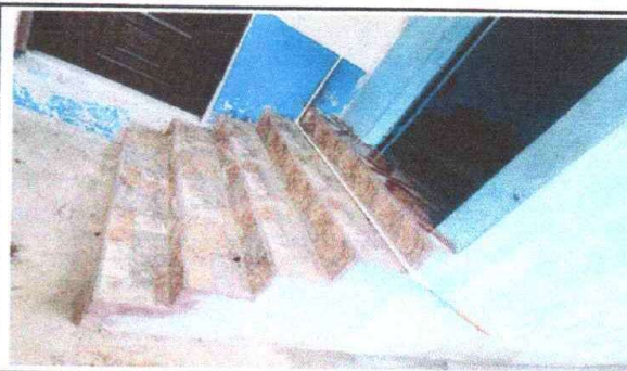
Foto 12: Reparación de gradas de concreto
