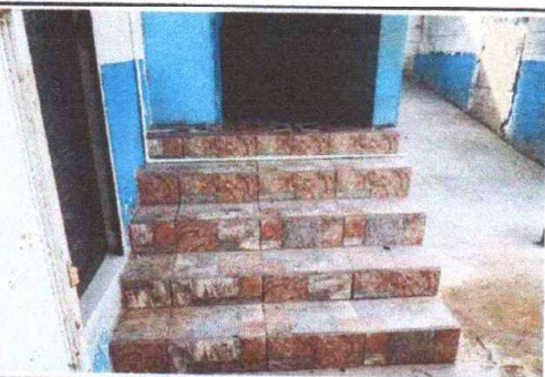
Foto 11: Reparación de gradas de concreto
