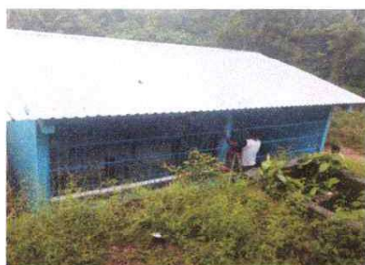
Foto 3: Sustrucción de balcones de metal.
