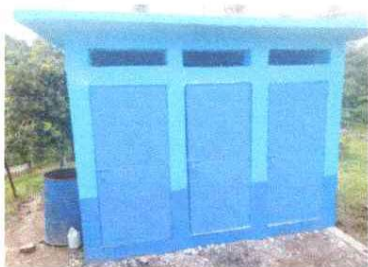
Foto 1: Sustrucción de puertas de metal en baños.
