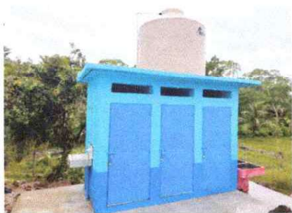
Foto1: Instalación de lavamanos, pila y depósito de agua.
