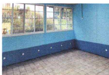
Foto 4: Sustitución de piso cerámico.
