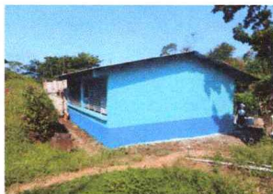
Foto 5: Pintura en muros exteriores e interiores.
