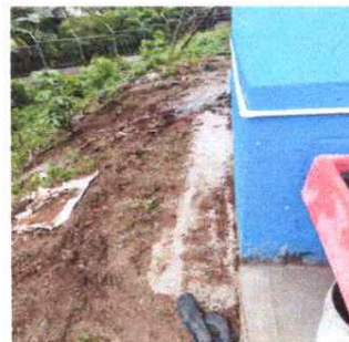
Foto 2: Instalación de red de drenaje para lavamanos y pila.
