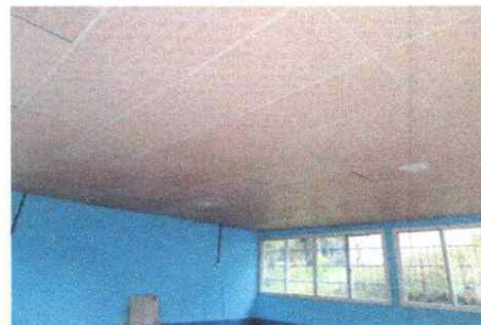
Foto 6: Instalación de cielo falso en aula.
