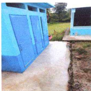
Foto 3: Sustitución de banquetta de concreto en el área de baños.
