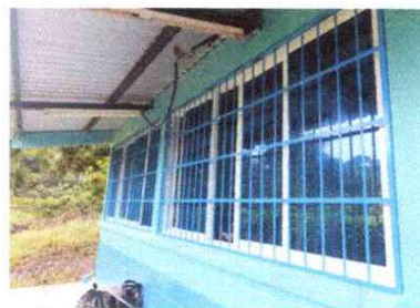
Foto 2: Ventanas sustición de vidrios por ventanas de PVC.
