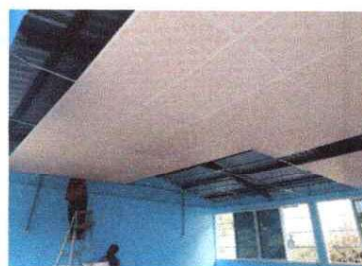
Foto 6: Instalación de cielo falso en aula.
