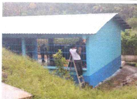
Foto 3: Sustitución de balcones de metal.
