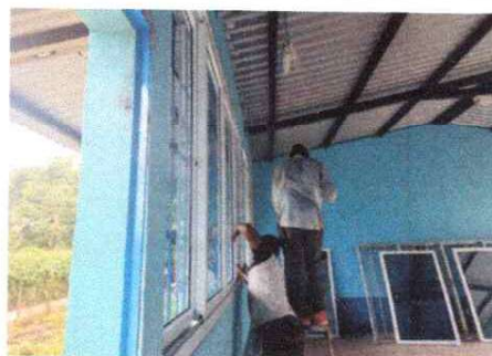
Foto 2: Ventanas sustitución de vidrios por ventanas de PVC.
