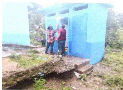
Foto1: Sustitución de puertas de metal en baños.
