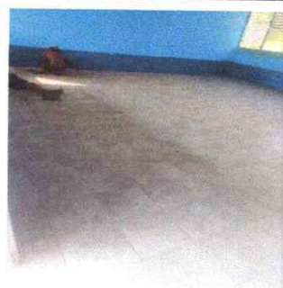
Foto 4: Sustitución de piso cerámico.
