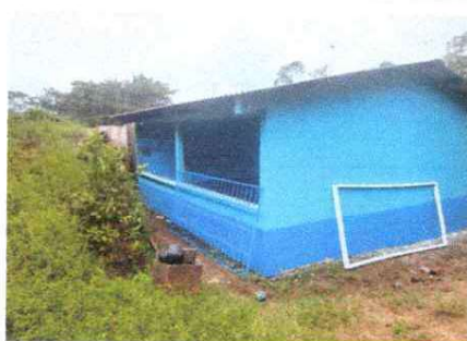
Foto 5: Pintura en muros exteriores e interiores.
