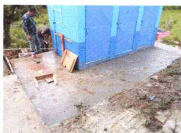
Foto 3: Sustitución de banqueta de concreto en el área de baños.
