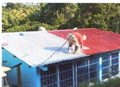
Foto 5: Mantenimiento preventivo en láminas.
