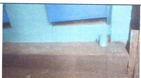
TUBERÍA PVC LÍNEA PRINCIPAL DE AGUAS NEGRAS YA DEBIDAMENTE INSTALADA
