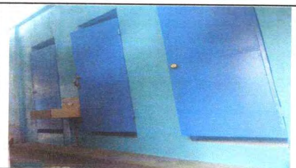
SUSTITUCIÓN DE PUERTAS DE MADERA
