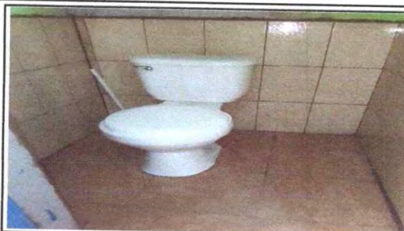
TAZAS DE SANITARIO DEBIDAMENTE INSTALADAS
