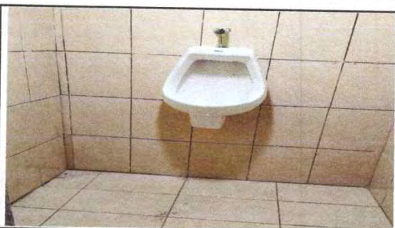
MINGITORIO YA INSTALADO
