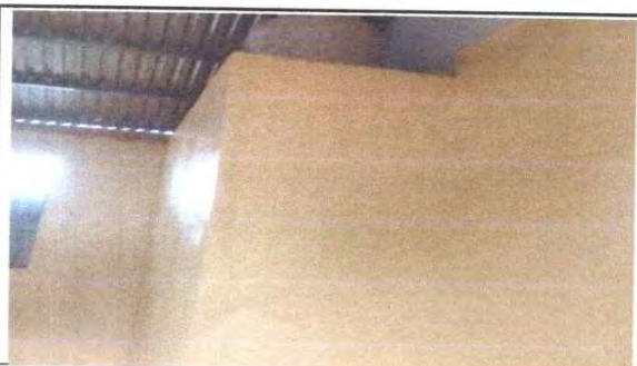
REPELLO EN PARED INTERNA Y EXTERNA DE SERVICIOS SANITARIOS
