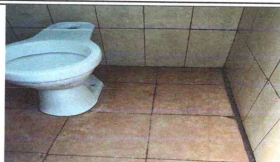
INSTALACIÓN DE PISO CERÁMICO EN SERVICIOS SANITARIOS
