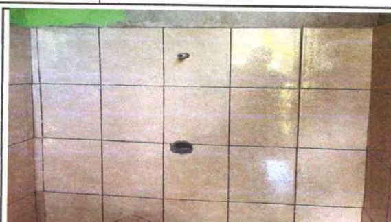
LÍNEA PRINCIPAL DE AGUA DEBIDAMENTE INSTALADA
