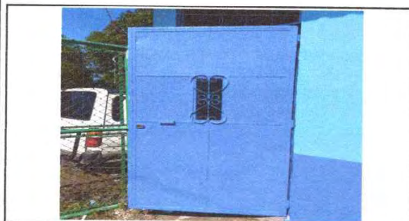
PUERTAS DE METAL CON SU DEBIDO MANTENIMIENTO
