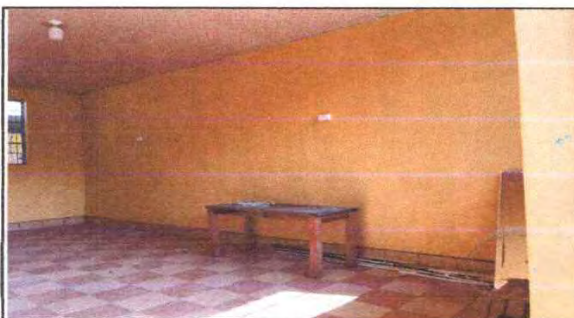
PAREDES INTERNAS DE AULAS PINTADAS
