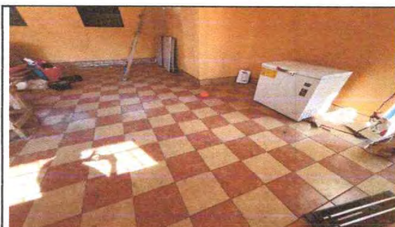
AULAS DEL INED POR COMPLETO CON CERÁMICO
