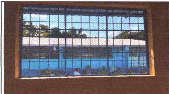
BALCON YA REMOZADO E INSTALADO
