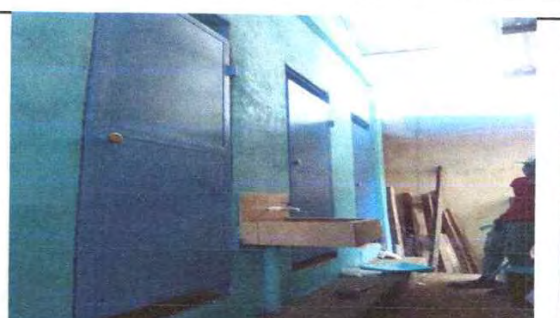
SUSTITUCIÓN DE PUERTAS DE METAL PARA SERVICIOS SANITARIOS
