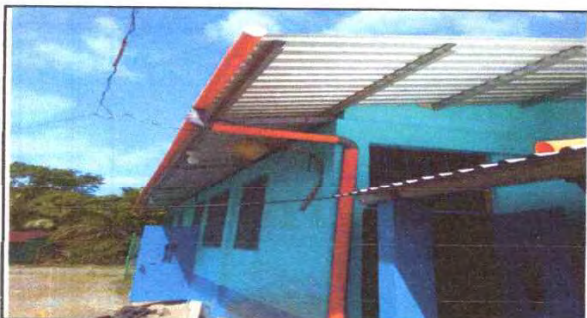
INSTALACIÓN DE BAJADA PLUVIAL
