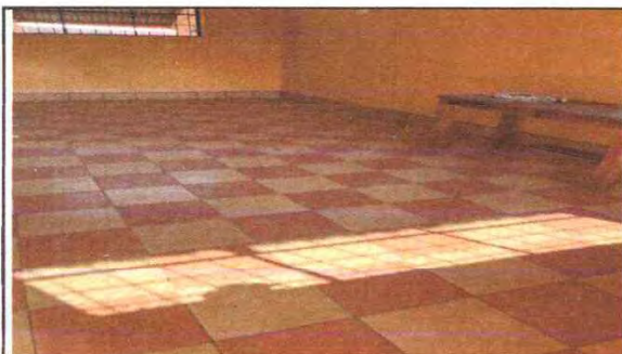
CERÁMICO YA INSTALADO POR COMPLETO
