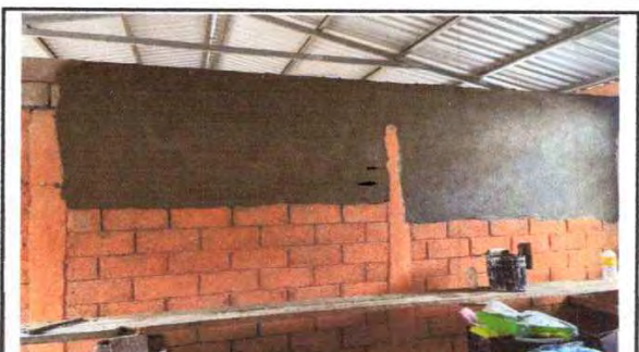
REPELLO EN PARED INTERNA DE AULAS DE 15 MTS X 2.7 MTS
