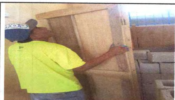
SUSTITUCIÓN DE PUERTAS DE MADERA
