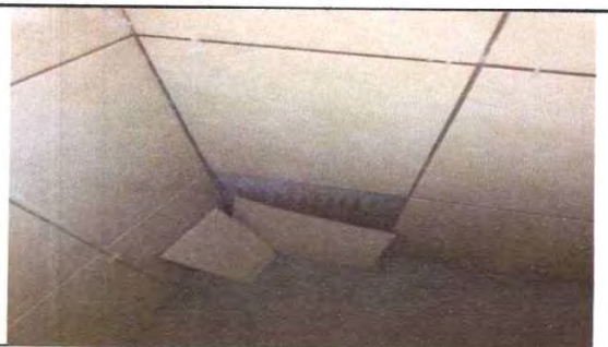
SUSTITUCIÓN DE AZULEJO EN SERVICIOS SANITARIOS
