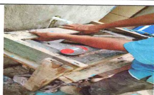
INSTALACIÓN DE LAVAMANOS
