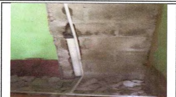
INSTALACIÓN DE 25 ML DE LINEA PRINCIPAL DE RED DE AGUA POTABLE
