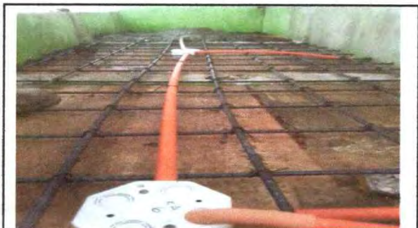
INSTALACIÓN DE SISTEMA ELÉCTRICO EN EL INED ALDEA SAN MIGUELITO
