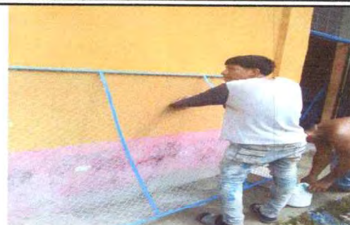
SE PROCEDE A LIJAR Y PINTAR CADA UNO DE LOS BALCONES
