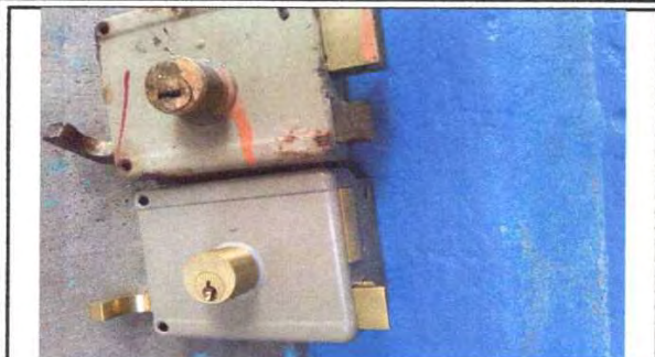
FOTOGRAFÍA DE CHAPA NUEVA DURANTE LA SUSTITUCIÓN DE LA CHAPA ANTIGUA
