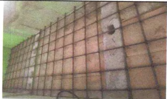
ESTRUCTURA DE METAL PARA LLEVAR A CABO LA SUSTITUCIÓN DE TERRAZA
