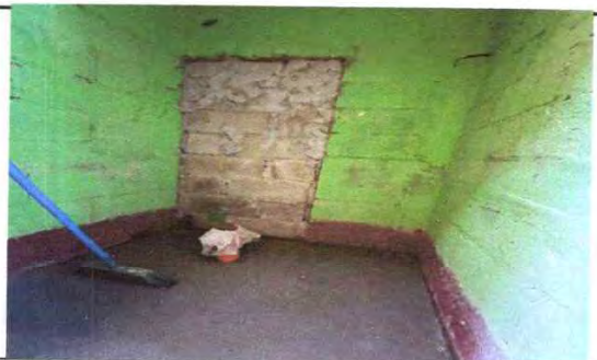
REPELLO EN PARED INTERNA Y EXTERNA DE SERVICIOS SANITARIOS
