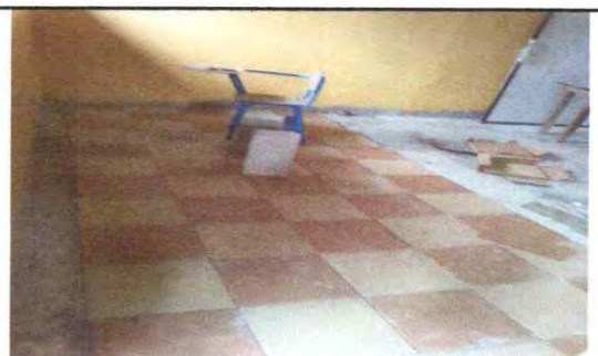
SE PROCEDE A SUSTITUIR EL PISO CERÁMICO EN LAS AULAS DEL INED SAN MIGUELITO
