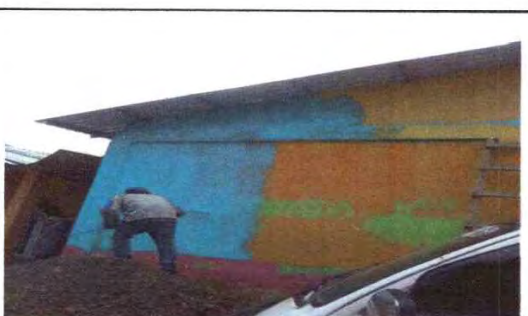
SE PROCEDE A PINTAR EL EXTERIOR DE LAS INSTALACIONES DEL INED SAN MIGUELITO
