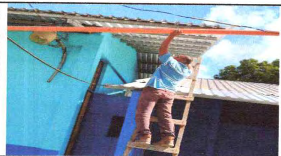
INSTALACIÓN DE BAJADA PLUVIAL
