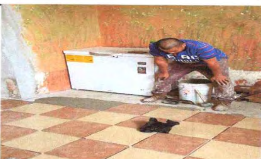
SE OBSERVA AL ALBAÑIL ACOMODANDO CADA UNA DE LAS PIEZAS DEL CERÁMICO
