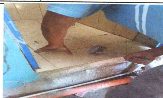
INSTALACIÓN DE PISO CERÁMICO EN SERVICIOS SANITARIOS
