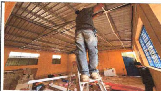
INSTALACIÓN DE CIELO FALSO EN LAS AULAS DEL INED SAN MIGUELITO
