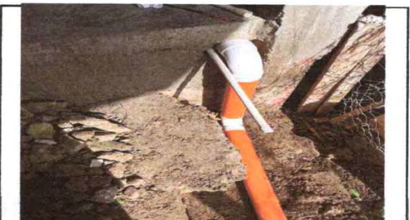
SUSTITUCIÓN DE 10 ML DE TUBERÍA PVC LÍNEA PRINCIPAL DE AGUAS NEGRAS
