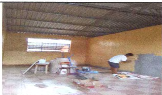
SE PROCEDE A PINTAR EL INTERIOR DE LAS INSTALACIONES DEL INED SAN MIGUELITO
