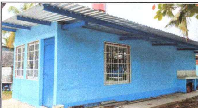
FOTO: REMOZAMIENTO DE VENTANA Y BALCON FINALIZADO.
