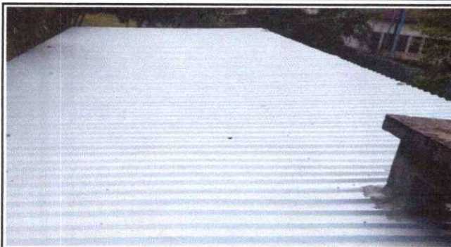
FOTO 07: FINALIZACIÓN DEL TECHADO DE BODEGA REMOZADA
