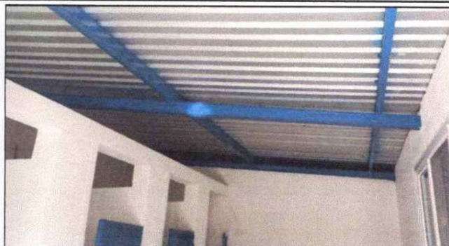
FOTO 08: INTERIOR DE BODEGA REMOZADA EN SU TOTALIDAD
