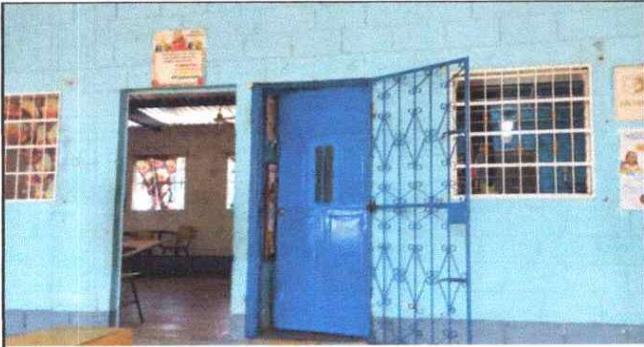
FOTO 03: FINALIZACION DE INSTACIÓN DE PUERTA.
