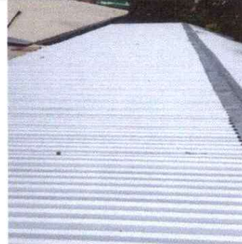
FOTO 02: LÁMINAS NUEVAS COLOCADAS.
