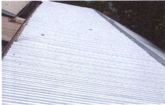
FOTO 01: FINALIZACIÓN DE SUSTITUCIÓN DE LÁMINAS.
