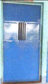
FOTO 05: PUERTA REPARADA EN SU TOTALIDAD.
