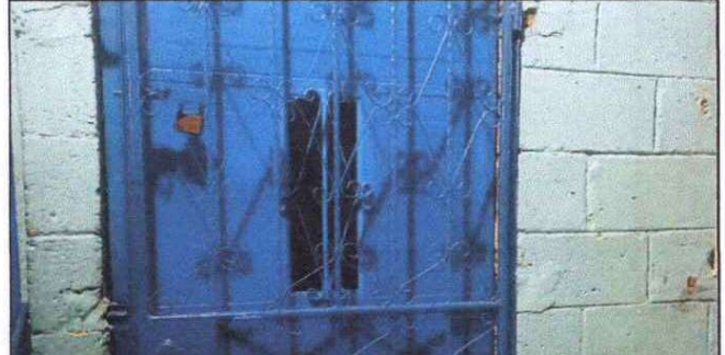
FOTO 06: SUSTITUCION DE PUERTA FINALIZADA
