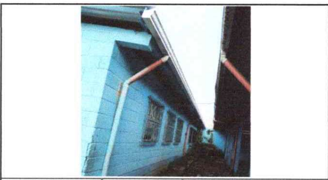
FOTO 11: FINALIZACIÓN DE SUSTITUCIÓN DE CANALES Y BAJADA DE AGUA PLUVIAL.
