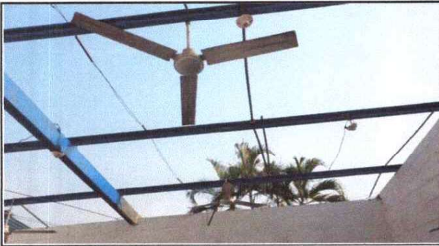
FOTO 01: SUSTITUCIÓN DE TECHO.
