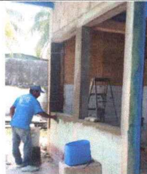
FOTO 10: REMOZAMIENTO DE DOS VENTANAS.
