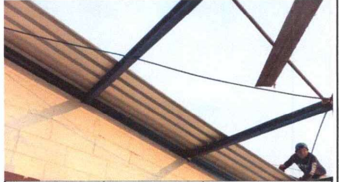
FOTO 02: COLOCACIÓN DE LAS NUEVAS LÁMINAS.
