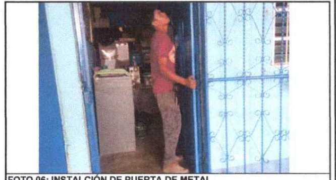
FOTO 06: INSTALCIÓN DE PUERTA DE METAL.
