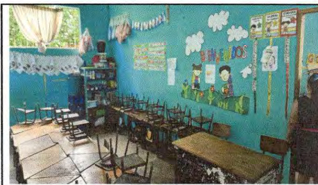
Foto 10: SUMINISTRO Y COLOCACION DE TABLA YESO SUSTITUYENDO EL QUE ESTA EN MAL ESTADO
