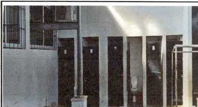
Foto 6: SUMINISTRO E INSTALACION DE PUERTAS CON PASADOR
