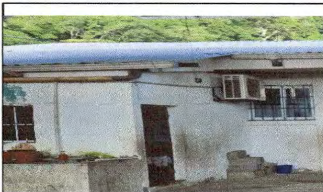
Foto 3: SUMINISTRAR E INSTALAR BAJADAS DE AGUA
