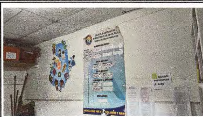
Foto 8: AMPLIACION MURO EN AULA CON REFUERZO ESTRUCTURAL
