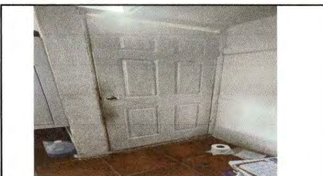
Foto 11: REMOZAMIENTO DE SERVICIO SANITARIO.
