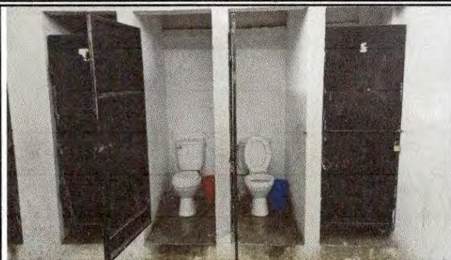
Foto7: SUMINISTRO E INSTALACION DE PISO CERAMICO ANTIDESLIZANTE Y AZULEJO EN BAÑOS
