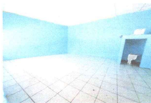
Foto 2: Instalación de piso cerámico
