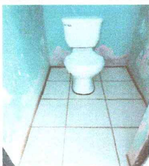
Foto 5: Instalación de tasa sanitaria
