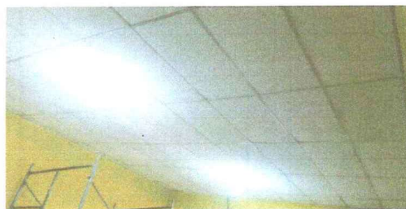
Foto 4: Instalación de cielo falso
