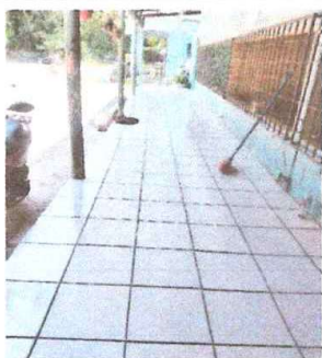
Foto 3: Instalación de piso cerámico en corredor
