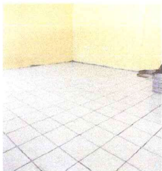
Foto 1: Instalación de piso cerámico
