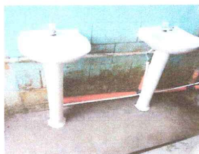
Foto 6: Instalación de lavamanos
