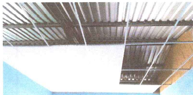
Foto 6: Instalación de cielo falso
