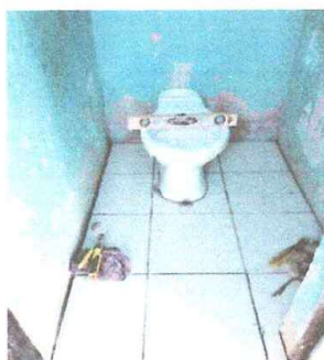
Foto 5: Instalación de tasa sanitaria
