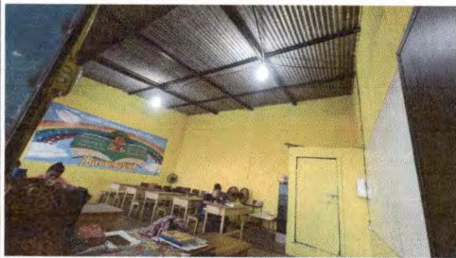
Foto 7: REMOZAMIENTO DE TECHO, SUMINISTRO E INSTALACION DE CIELO FALSO
