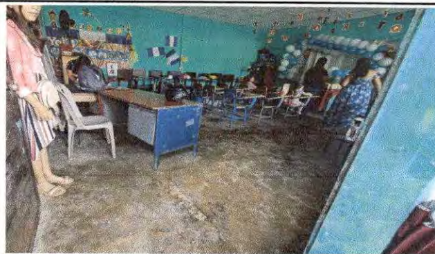
Foto 4: SUMINISTRO E INSTALACION DE PISO CERAMICO ANTIDESLIZANTE
