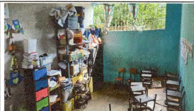
Foto 6: MODULO "A" AULAS REMOZAMIENTO DE PISO
