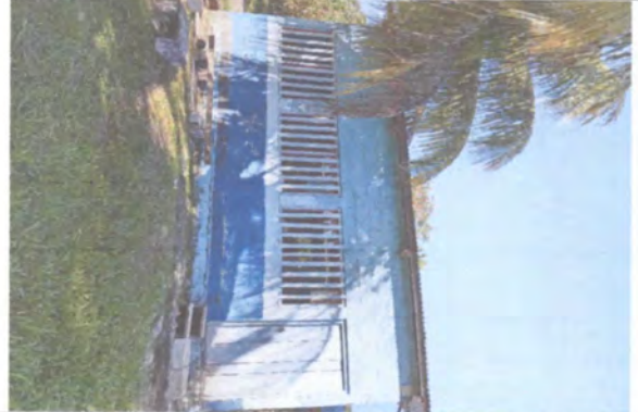
Sustitución de puerta de madera por, puerta de metal, y ventanas de madera por ventanas de metal aula4
