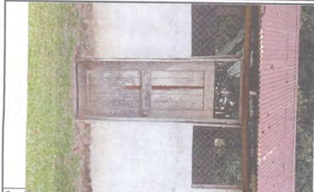
Sustitución de lamina, por lamina troquelada aluzinc calibre 26, sustitución de estructura de madera por, estructura de metal, sustitución de puerta de madera por puerta de metal. COCINA
