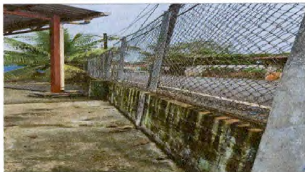
Foto 3: MODULO "A" MURO PERIMETRAL AMPLIACION MURO EN AULA CON REFUERZO ESTRUCTURAL
