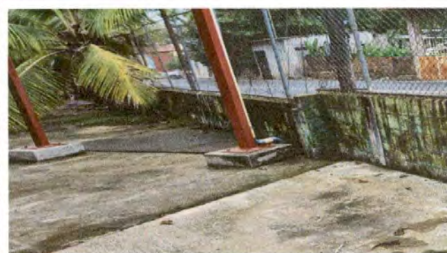
Foto 4: MODULO "A" REMOZAMIENTO DE MURO PERIMETRAL AMPLIANDO ALTURA CON REFUERZO ESTRUCTURAL.
