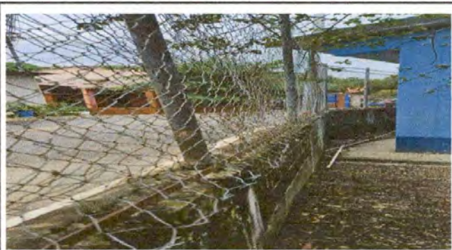
Foto 10: MODULO "A" REMOZAMIENTO DE MURO PERIMETRAL
