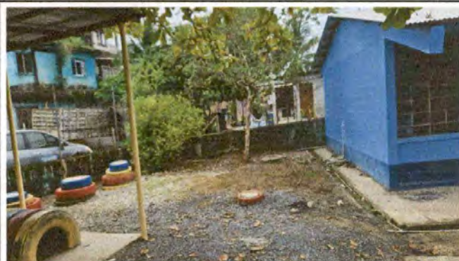
Foto 8: MODULO "A" REMOZAMIENTO DE MURO PERIMETRAL DE LA ESCUELA.
