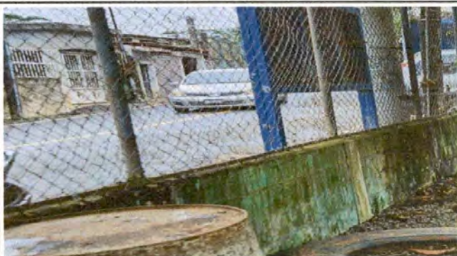
Foto 6: MODULO "A" MURO PERIMETRAL
