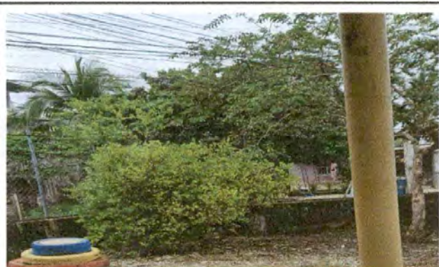
Foto 9: MODULO "A" AMPLIACION DE MURO EN CENTRO EDUCATIVO
