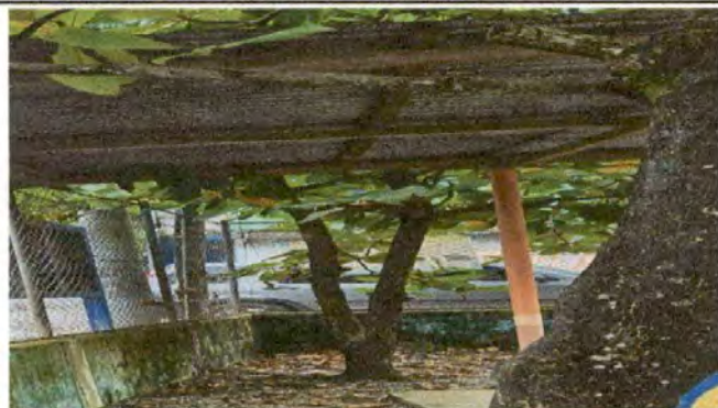
Foto 7: MODULO "A" MURO PERIMETRAL AMPLIACION MURO EN AULA MCON REFUERZO ESTRUCTURAL
