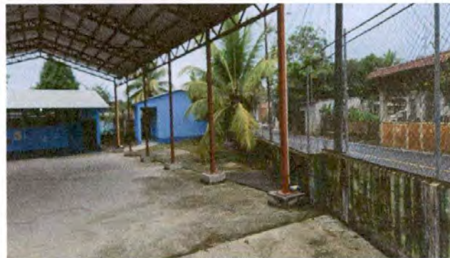
Foto 2: MODULO "A" REMOZAMIENTO DE MURO PERIMETRAL
