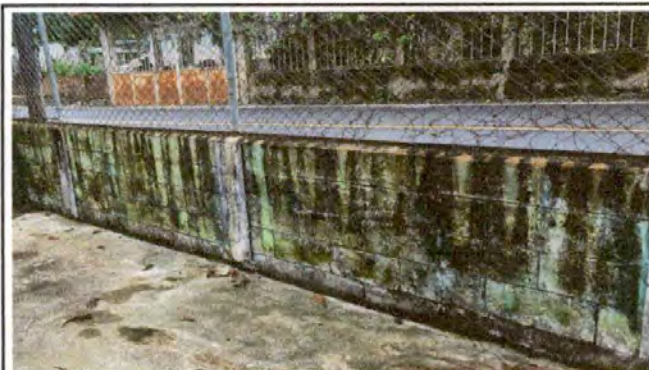
Foto 5: MODULO "A" MURO PERIMETRAL AMPLIACION MURO EN AULA CON REFUERZO ESTRUCTURAL
