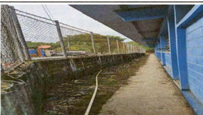
Foto 11: MODULO "A" MURO PERIMETRAL AMPLIACION MURO CON REFUERZO ESTRUCTURAL EN CENTRO EDUCATIVO PARA MAYOR SEGURIDAD
