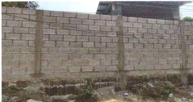
REPARACION DE MURO PERIMETRAL PARTE DE ENFRENTÉ
