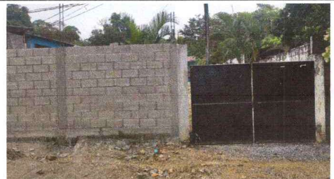
REPARACION MURO PERIMETRAL PARTE FRONTAL
