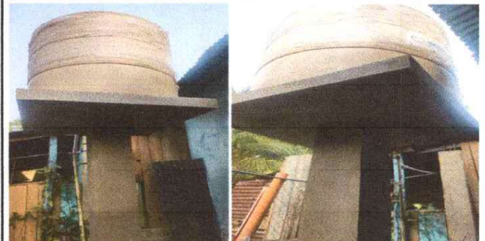
SUSTITUCION DE ACCESORIOS Y BASE PARA DEPOSITO DE AGUA
