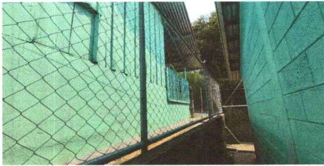
REPARACION DE MURO PERIMETRAL CON BLOCK Y MALLA Y TUBO
