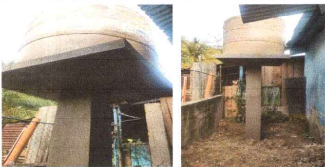
SUSTITUCION DE DEPOSITO DE AGUA
