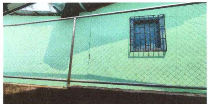
REPARACION DE MURO PARTE ATRÁS DEL ESTABLECIMIENTO
