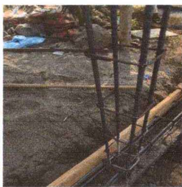
FOTO 3 REPARACION DE MURO PERIMETRAL PARTE DE LADO IZQUERDO
