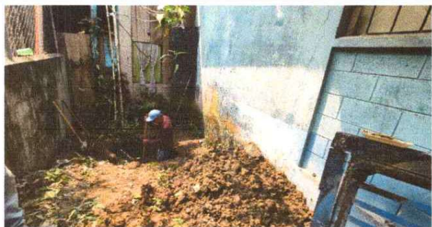
SE SUSTITUIRA LA BASE ANTERIOR DE DEPOSITO DE AGUA POR BASE DE CONCRETO CON COLUMNA Y TERRAZA PARA EL TANQUE
