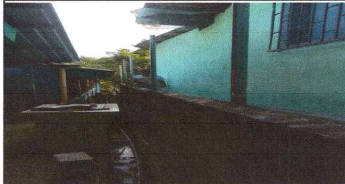
FOTO 2: RAPARACIÓN DE MURO PERIMETRAL DE ATRÁS DEL ESTABLECIMIENTO
