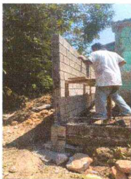
FOTO 3 REPARACION DE MURO PERIMETRAL PARTE DE LADO IZQUERDO
