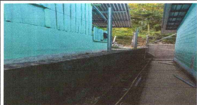
FOTO 1: REPARACION DE MURO PERIMETRAL CON BLOCK, MAYA Y TUBO DE LADO IZQUERDA
