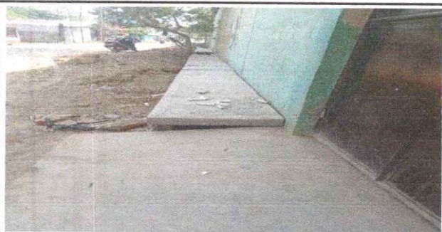
Foto 5: Colocación de tapaderas de concreto.
