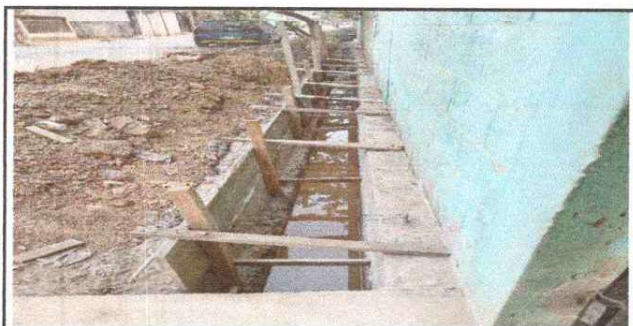
Foto 5: Fundición de concreto en cuneta.
