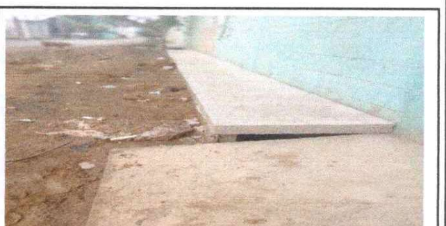
Foto 6: Colocación de tapaderas de concreto a cuneta.
