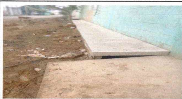
Foto 8: Colocación de tapaderas de concreto para cuneta.
