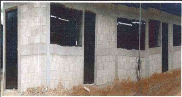
Foto 9: Colocación de puertas y balcones de aulas uno, dos y tres,
