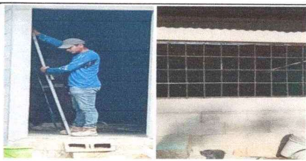
Foto 6: Reinstalación de puertas y balcones de aulas uno, dos y tres.
