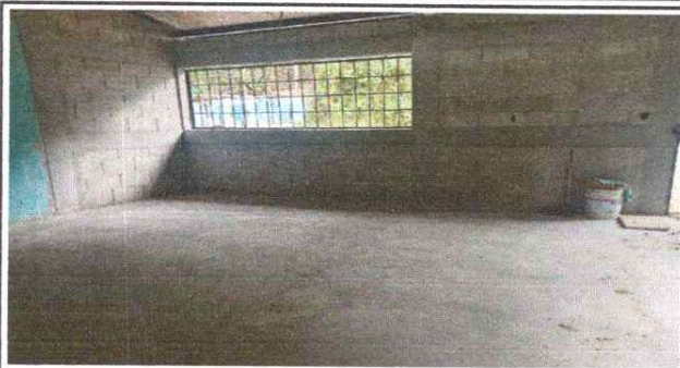
Foto1: Piso de torta de cemento en aula uno.
