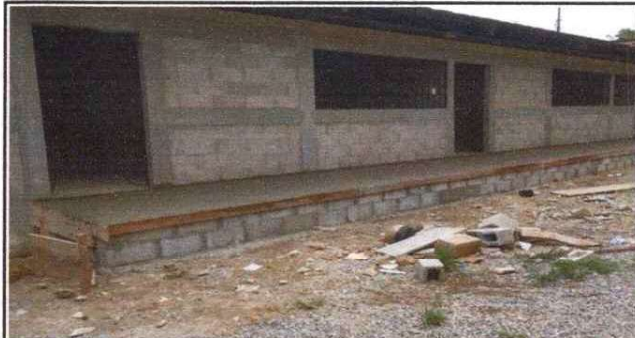
Foto 10: levantado del Piso de corredor
