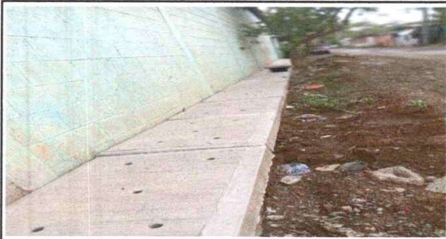
Foto 7: Colocación de tapaderas de concreto para cuneta
