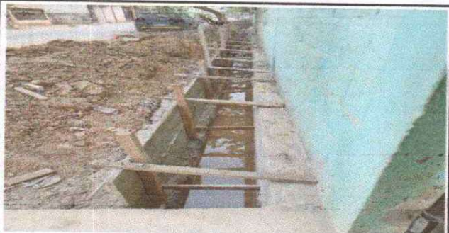
Foto 11: Elaboración de las paredes de la cuneta.
