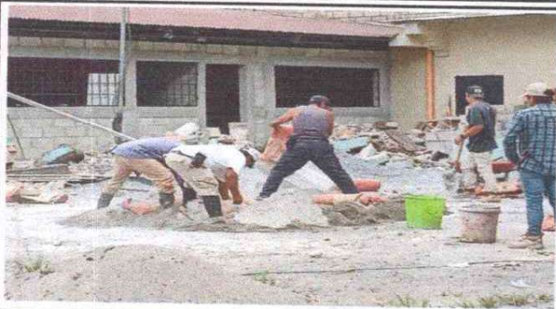
Foto 7: Preparación de mezcla para echar torta de cemento en las aulas uno, dos y tres.
