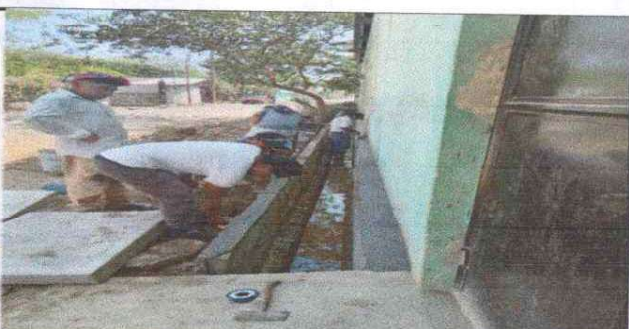
Foto 12: Preparación para la colocación de las tapaderas de la cuneta.
