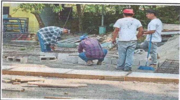
Foto 9: Preparación de parrillas para tapaderas de la cuneta.
