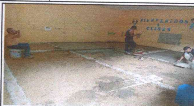
Foto 8: Elaboración de torta de cemento para piso en aulas uno, dos y tres.
