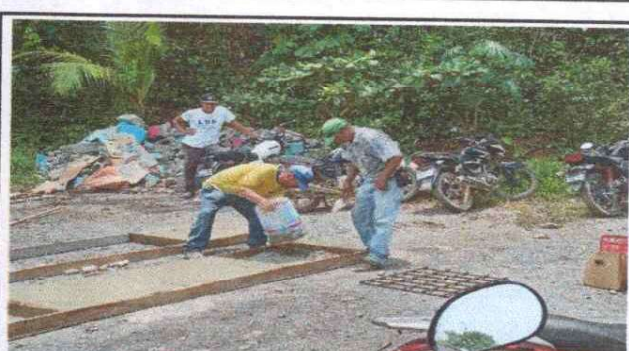
Foto 10: Elaboración de las tapaderas de la cuneta.
