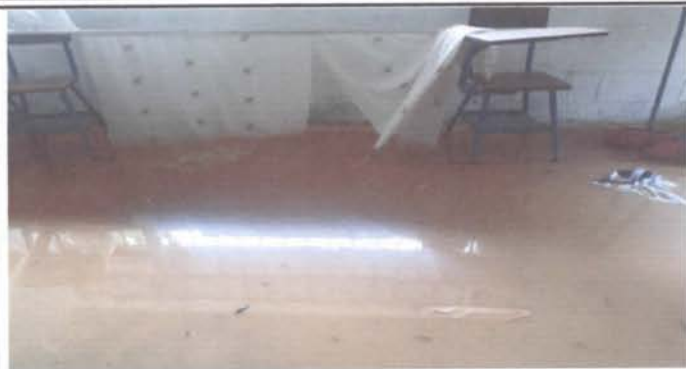
Foto 1: Levantado de piso de aula numero uno por inundación a causa de las fuertes lluvias por 31 años en servicio.
