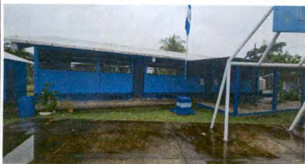
Foto1: MODULO "C" SUMINISTRO E INSTALACION DE PISO CERAMICO. EN PASILLO.
