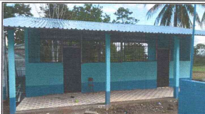
FOTO. 2 APLICACIÓN DE PINTURA
