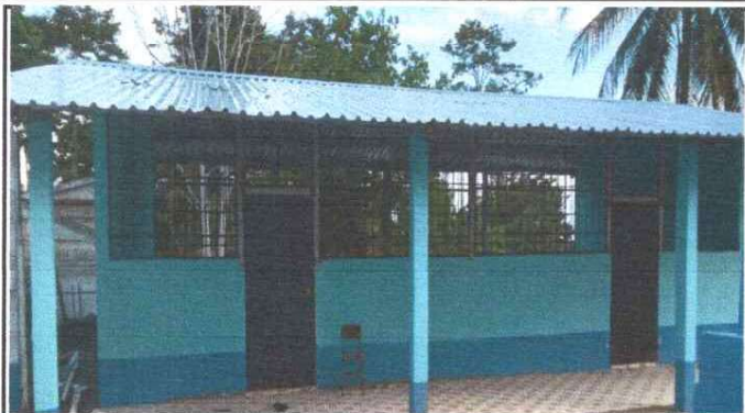
FOTO. 1 SUSTITUCION DE LAMINA
