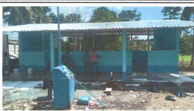
FOTO 2: APLICACIÓN DE PINTURA
