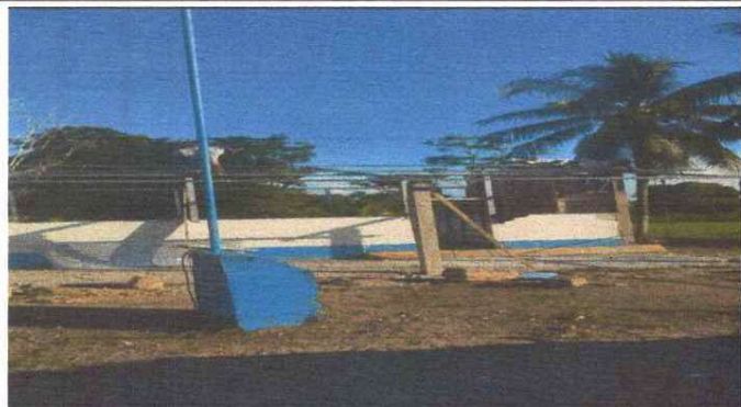
FOTO 1 SUSTITUCION DE LAMINA
