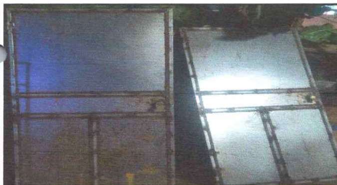
FOTO NO. 3 SUSTITUCION DE PUERTAS DE MADERA POR PUERTAS DE METAL
