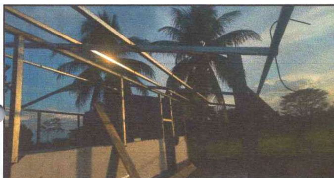
FOTO NO. 5 SUSTITUCION DE ESTRUCTURA DE MADERA POR ESTRUCTURA DE METAL.
