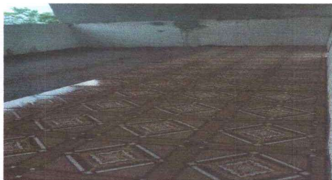
FOTO NO. 4 SUSTITUCION DE PISO DE TORTA POR PISO CERAMICO
