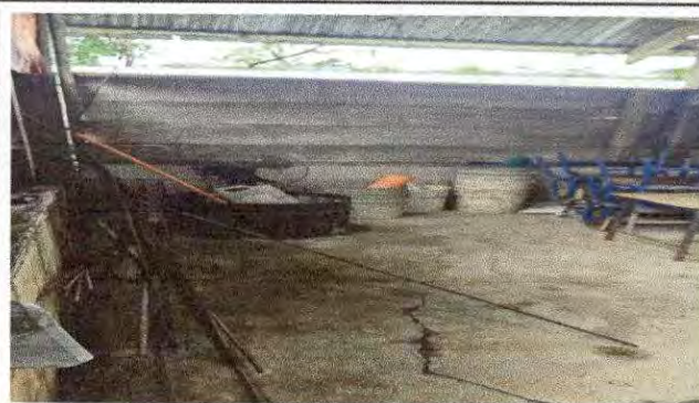
Foto 8: REMOZAMIENTO DE PISO DE AULA
