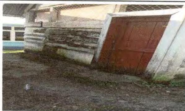
Foto 6: REMOZAMIENTO DE AULA
