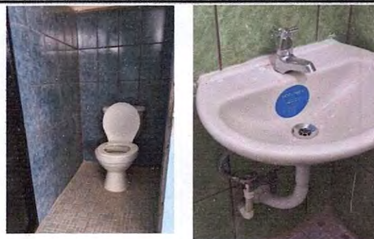
Foto 10: Suministro e instalación de lavamanos e inodoro.
