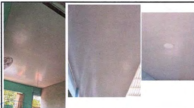
Foto 5: Suministro e instalación de cielo falso PVC
