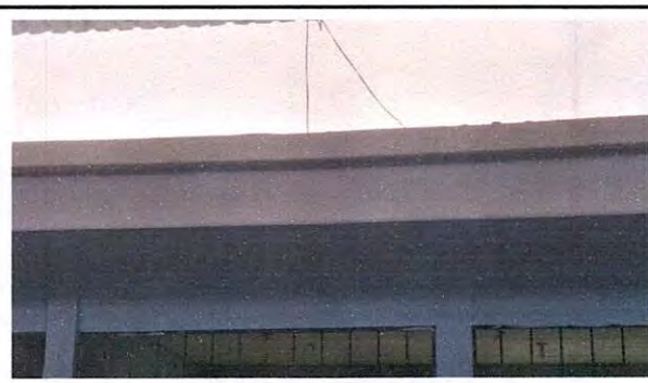
Foto 6: Suministro e instalación de canal
