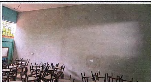
Foto 3: Mejoramiento de muro
