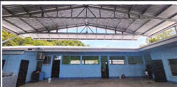
Foto 11: Aplicación de pintura
