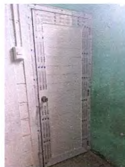
Foto 8: Suministro e instalación de puerta de PVC
