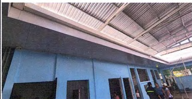
Foto 7: Suministro e instalación de canal
