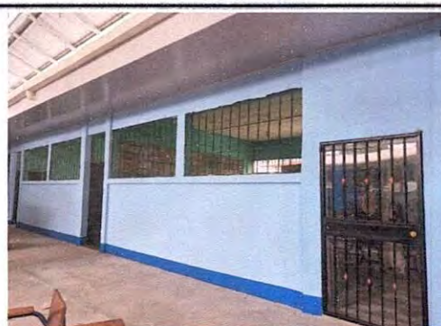
Foto 4: Suministro e instalación de cielo falso PVC
