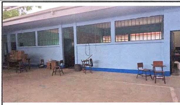
Foto2: Vista de la aplicación de pintura, cielo falso en pasillo y canal de PVC
