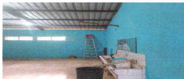
TRABAJO TERMINADO FOTO 2
