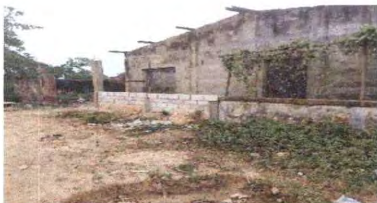
ANTES DEL REMOZAMIENTO FOTO 1
