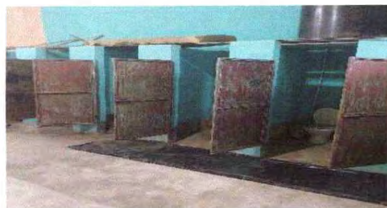
ANTES DEL REMOZAMIENTO FOTO 2
