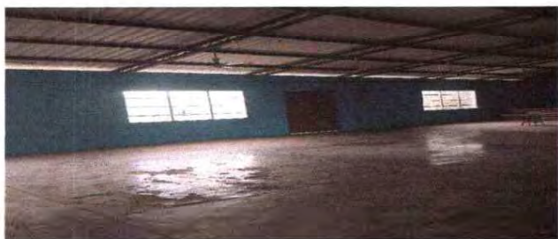
TRABAJO TERMINADO FOTO 1
