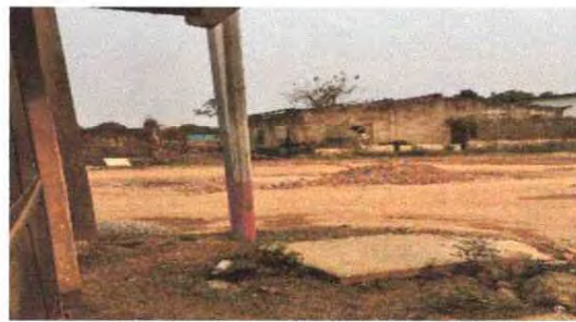
ANTES DEL REMOZAMIENTO FOTO 2
