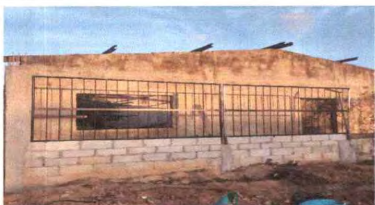
TRABAJO TERMINADO FOTO 1
