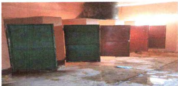
ANTES DEL REMOZAMIENTO FOTO 1
