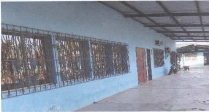
Reparacion de balcones y pintura
