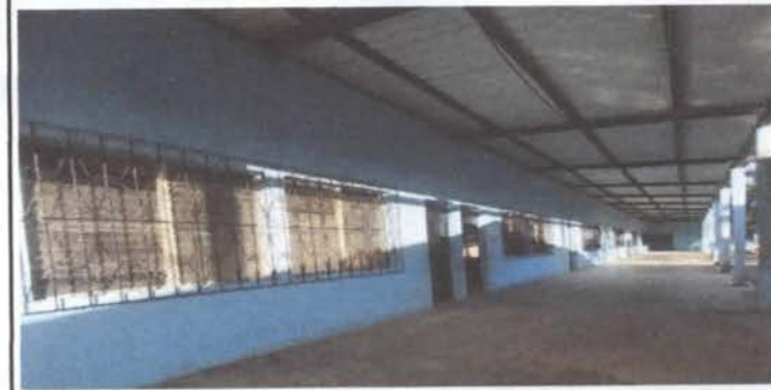
Reparación de balcones y pintura
