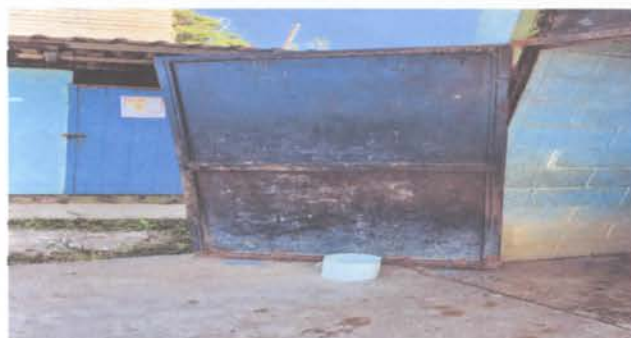
SUSTITUCION DE DOS PUERTAS DE METAL
