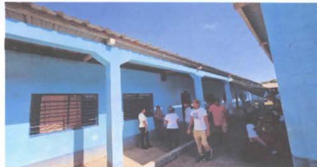
SUSTITUCION DE PINTURA
