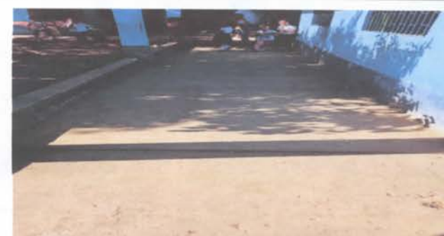
SUSTITUCION DE PISO DE CONCRETO
