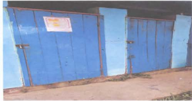
SUSTITUCION DE PUERTAS DE MADERA POR METAL
