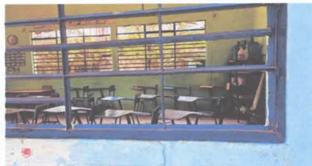
SUSTITUCION DE BALCON
