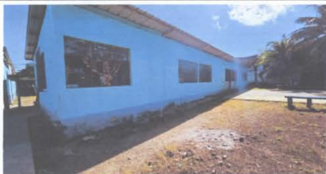
SUSTITUCION DE PINTURA AULAS EXTERIORES
