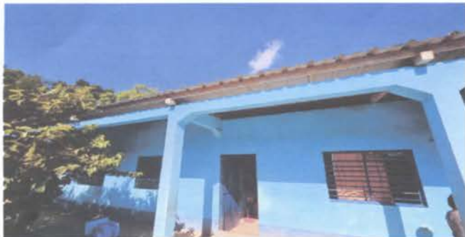
SUSTITUCION DE PINTURA
