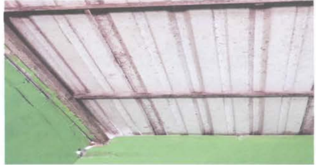
SUSTITUCION DE LAMINA TROQUELADA CALIBRE 26 DE AULAS
