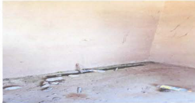
SUSTITUCION DE TUBERIA DE DRENAJE
