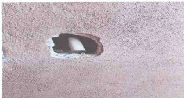
SUSTITUCION DE CABLEADO ELECTRICO
