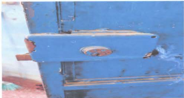
SUSTITUCION DE CHAPA YALE
