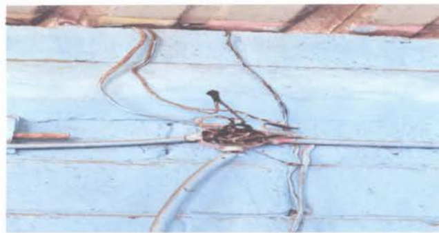
SUSTITUCION DUCTO DE AULAS
