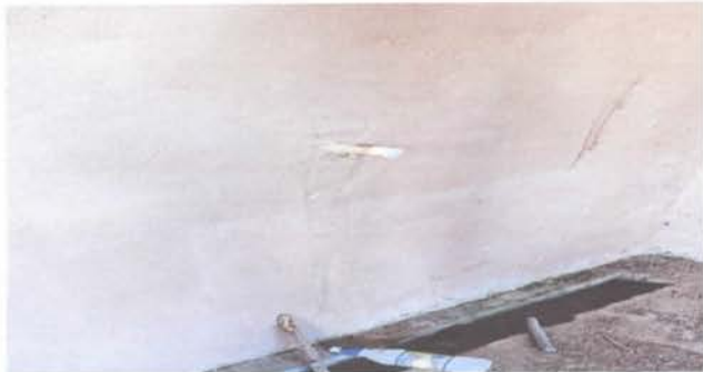
SUSTITUCION DE TUBERIA DE AGUA POTABLE
