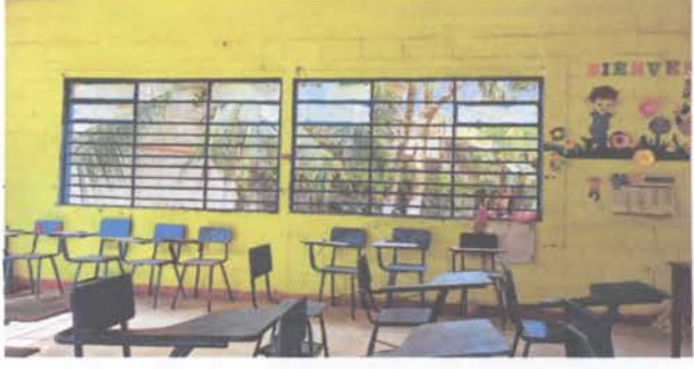
SUSTITUCION DE BALCONES
