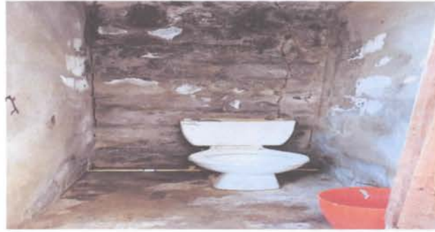
SUSTITUCION DE BAÑOS DE NIÑOS
