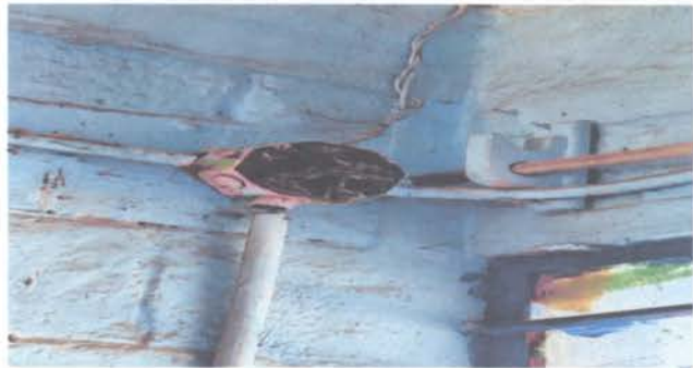
SUSTITUCION DE DUCTO ELECTRICO DE AULAS
