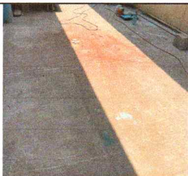
Foto 11: Pañuelos mejorados en pasillo exterior
