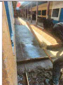
Foto 8: Mejoramiento de pañuelos con concreto
