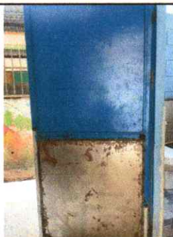
Foto 11: Remozamiento de puerta de metal
