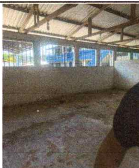
Foto 9: Contrapiso de aula finalizado
