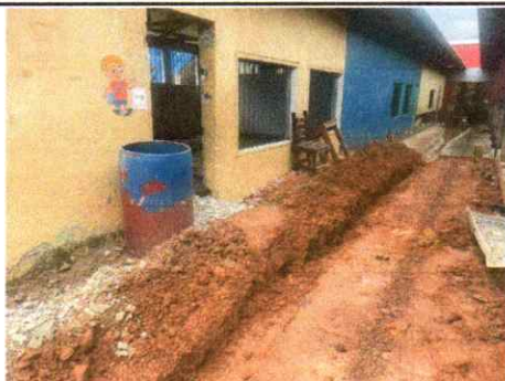
Foto 3: Zanjeo para tubería para agua pluvial
