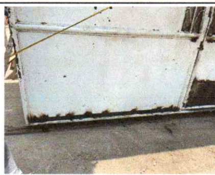
Foto 12: Remozamiento de portón, se niveló y soldó lámina nueva en ciertas áreas
