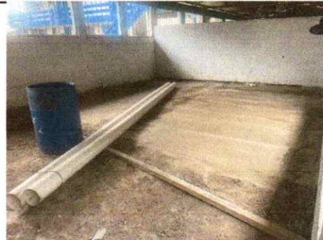
Foto 4: Mejoramiento de contrapiso
