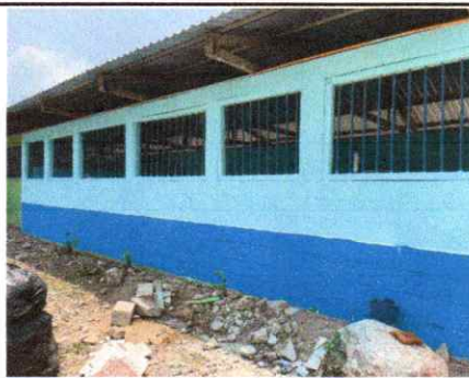
Foto 10: Pintura de muros exteriores
