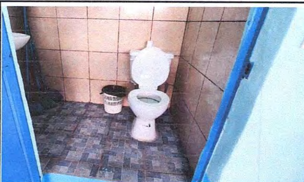
Foto 10: Suministro e instalación de piso cerámico antideslizante, azulejo.
