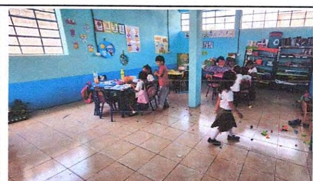
Foto 6: Suministro e instalación de piso cerámico antideslizante
