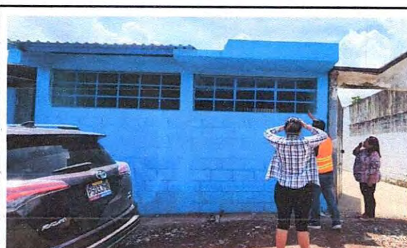
Foto 4: vista posterior del Aula remozada, se observa que aplico Repello + cernido y pintura en muros.
