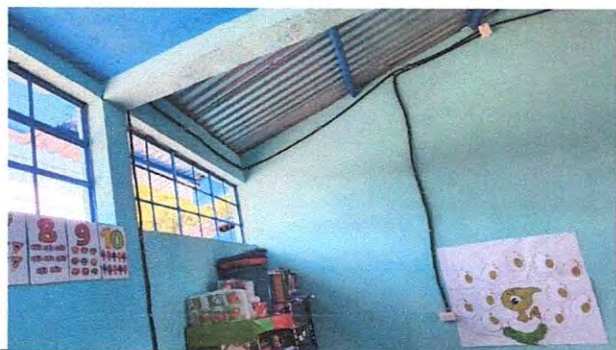
Foto 7: Suministro e instalación de red eléctrica interior
