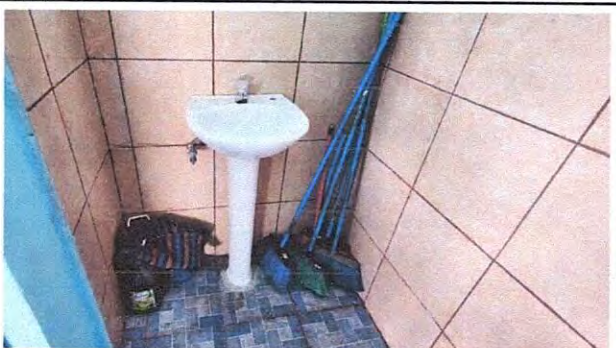
Foto 11: Suministro e instalación de lavamanos,
