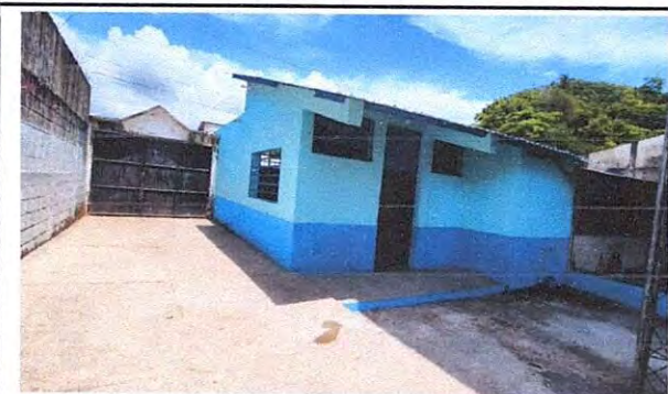
Foto 3: Vista del aula remozada, se observa que aplico Repello + cernido y pintura en muros, y el cambio de techo.
