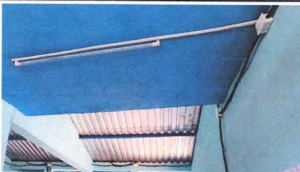
Foto 9: Suministro e instalación de lámparas led
