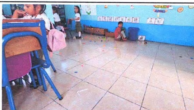
Foto 5: Suministro e instalación de piso cerámico antideslizante
