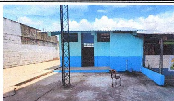
Foto2: vista frontal del Aula remozada, se observa que aplico Repello + cernido y pintura en muros.
