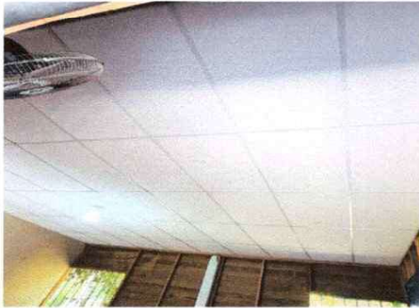
Foto 1: Instalación de cielo falso
