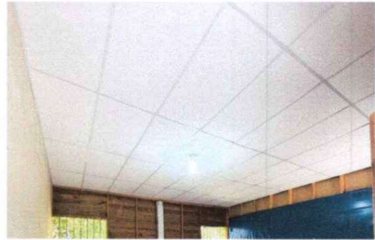
Foto 2: Instalación de cielo falso
