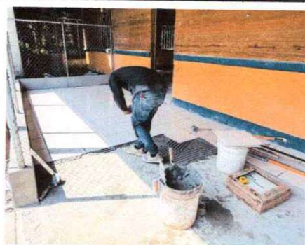
Foto 5: Instalación de Cerámico
