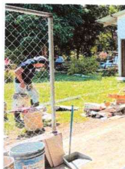
Foto 6: Instalación de malla
