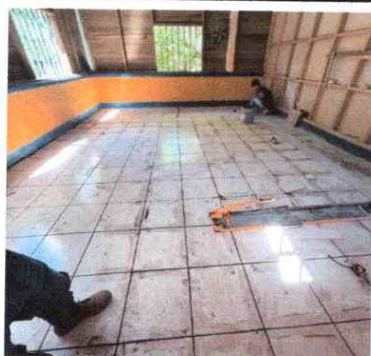
Foto 3: Instalación de cerámico
