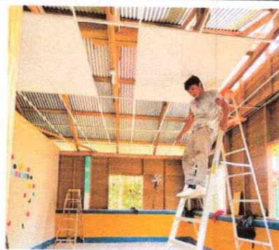
Foto 2: Instalación de cielo falso
