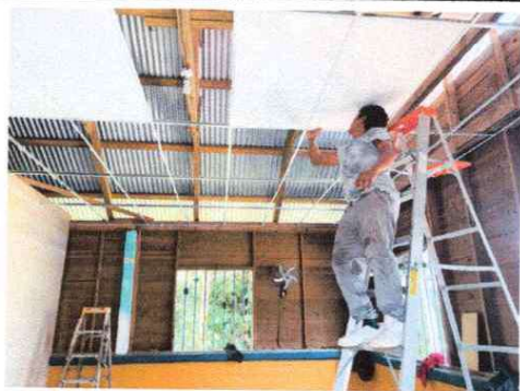
Foto 1: Instalación de cielo falso
