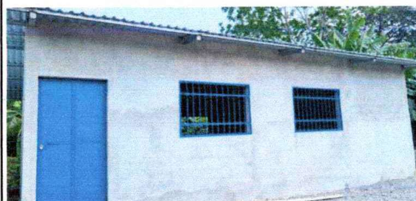
Foto 10: Suministro e instalación de BALCONES metálica y BALCONES metálica
