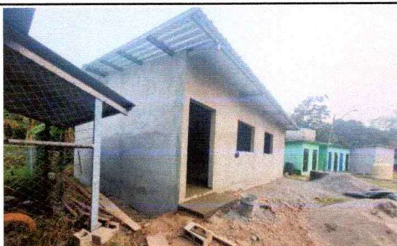
Foto 9: Suministro y colocación de repello.
