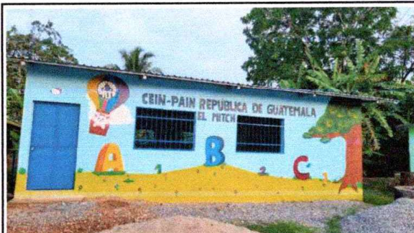
Foto 12: Finalización del remozamiento.
