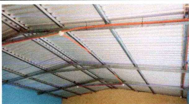
Foto 11: Suministro e instalación eléctrica en aula
