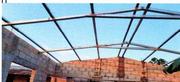
Foto 5: Suministro e instalación de estructura portante de metal
