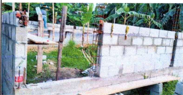
Foto1: Suministro y levantado de block, Soleras y columnas
