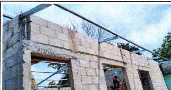
Foto 4: Suministro y levantado de block, Soleras y columnas, y instalación de estructura portante de metal
