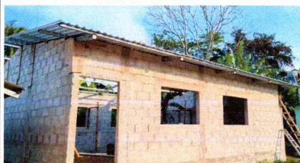
Foto 6: Suministro e instalación de lámina troquelada calibre 26
