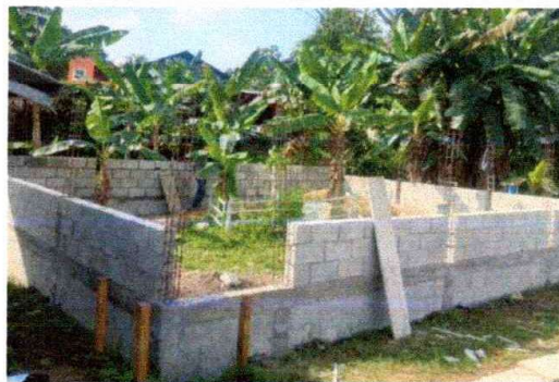
Foto2: Suministro y levantado de block, Soleras y columnas.
