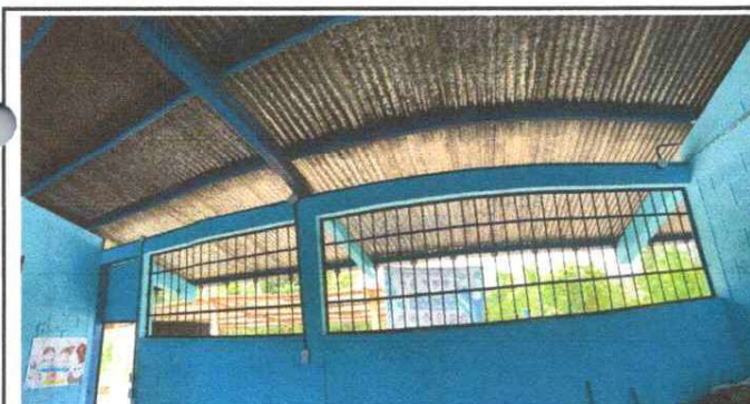
SUSTITUCION DE VENTAS POR BALCONES DE METAL
