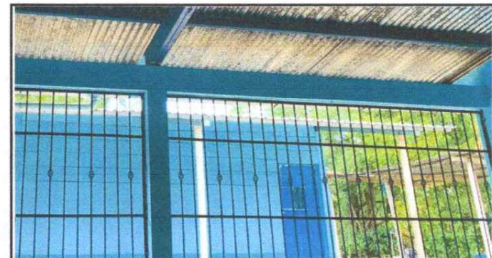
SUSSTITUCION DE VENTANAS POR BALCONES DE METAL
