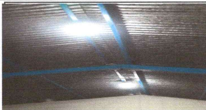
REPARACION DEL SISTEMA ELECTRICO
