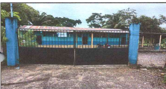
REPARACION DE PORTON
