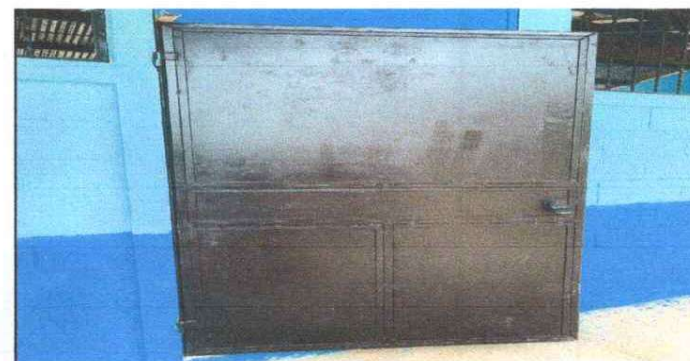
SUSTITUCION DE PUERTAS DE METAL
