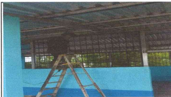
SUSSTITUCION DE VENTANAS POR BALCONES DE METAL
