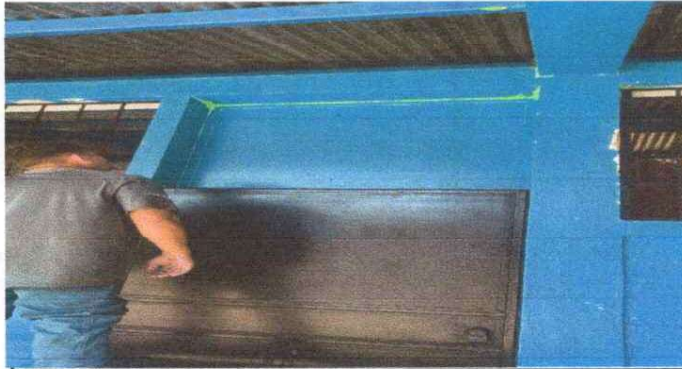
SUSTITUCION DE PUERTAS DE METAL
