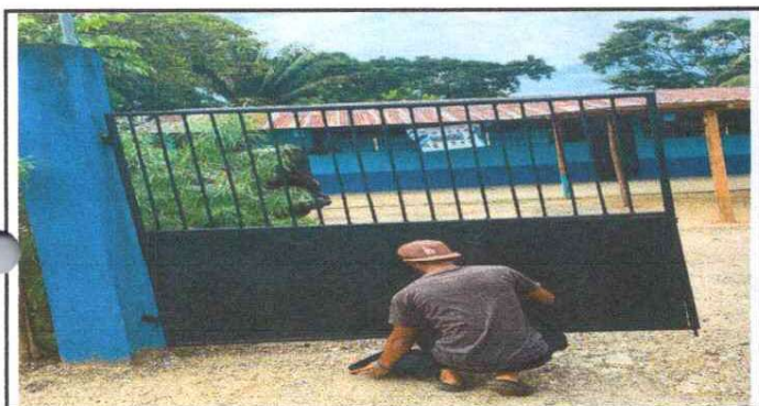
REPARACION DE PORTON
