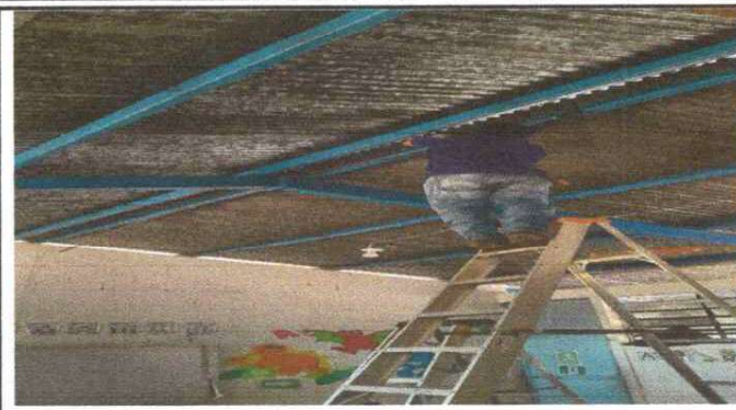
REPARACION DEL SISTEMA ELECTRICO
