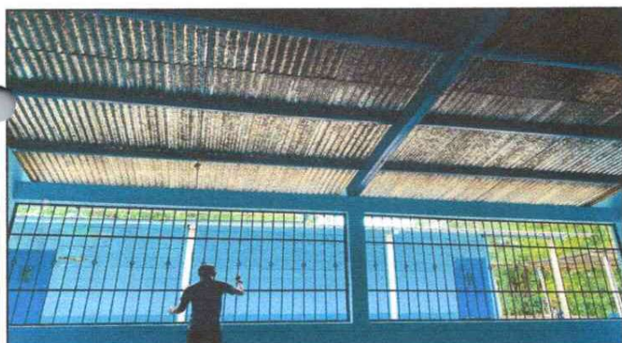
SUSTITUCION DE VENTAS POR BALCONES DE METAL
