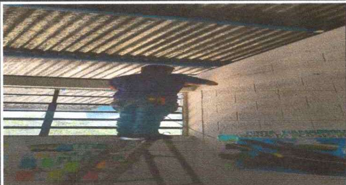
REPARACION DEL SISTEMA ELECTRRICO
