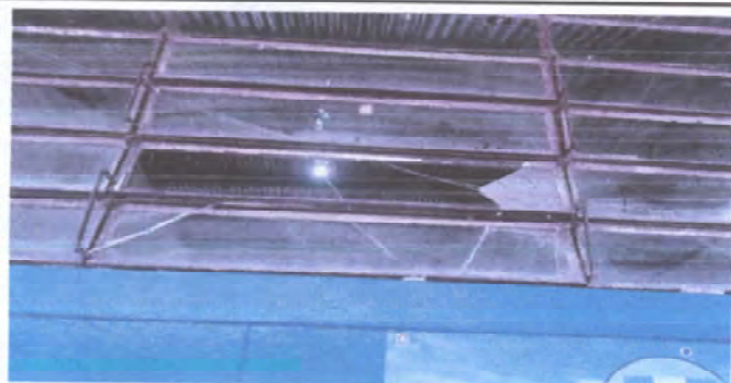
SUSTITUCION DE VENTAS POR BALCONES DE METAL
