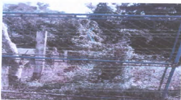
REPARACION DE PORTON
