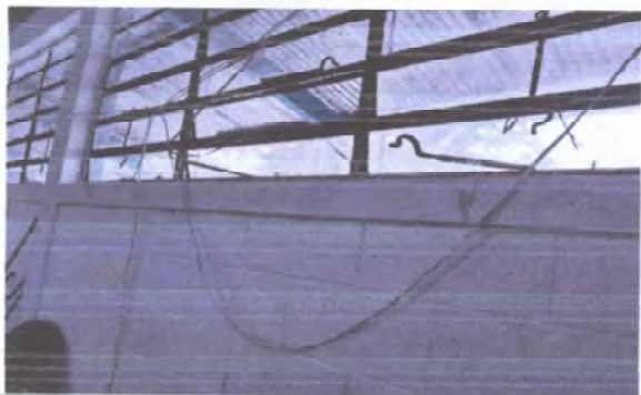
REPARACION DEL SISTEMA ELECTRRICO
