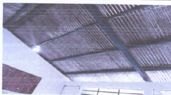
REPARACION DEL SISTEMA ELECTRICO
