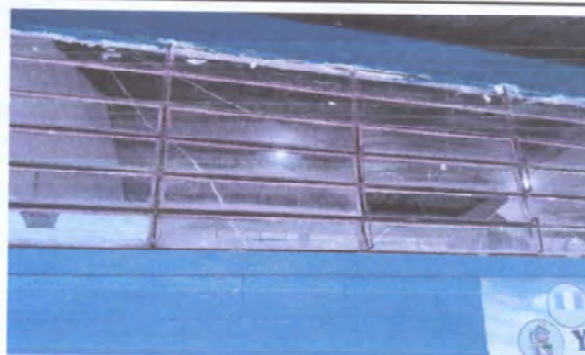
SUSSTITUCION DE VENTANAS POR BALCONES DE METAL
