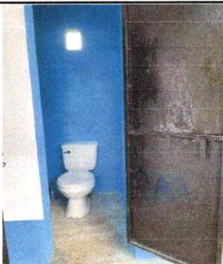
Foto 3: Sustitución de inodoros
