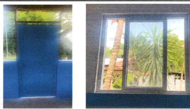
Foto 4: Sustitución de puertas y ventanas
