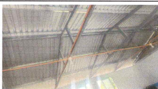
Foto 2: Sustitución de soporte de madera por metal
