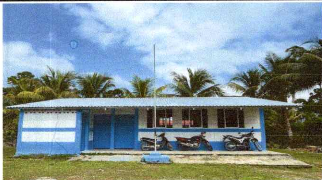
Foto1: Sustitución de láminas en 3 aulas y cocina
