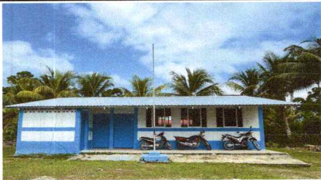
Foto1: Sustitución de láminas en 3 aulas y cocina
