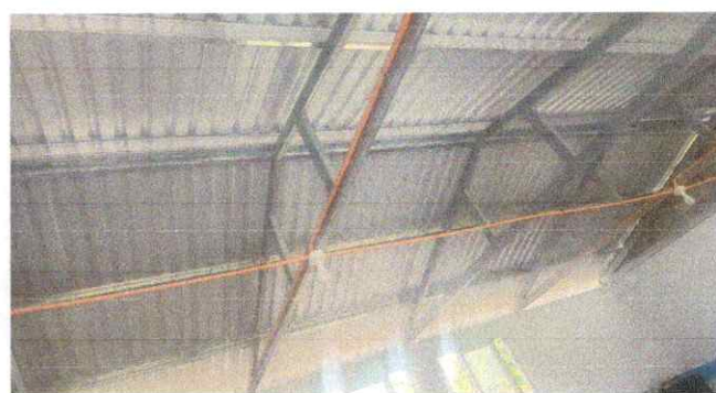
Foto 2: Sustitución de soporte de madera por metal
