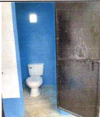
Foto 3: Sustitución de inodoros
