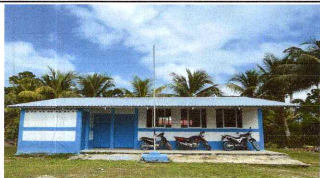
Foto1: Sustitución de láminas en 3 aulas y cocina
