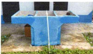
Foto 5: Sustitución de tubería para agua de distribución del pozo y sustitución de pila
