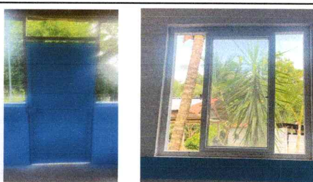
Foto 4: Sustitución de puertas y ventanas
