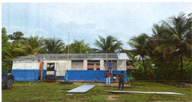
Foto1: Sustitución de láminas en 3 aulas y cocina
