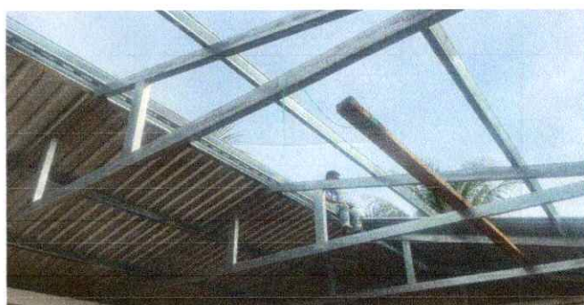
Foto 2: Sustitución de soporte de madera por metal
