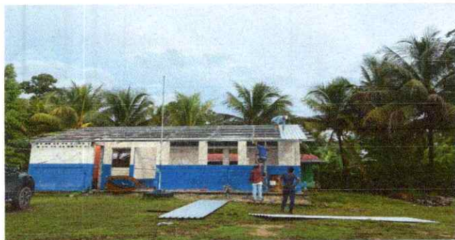
Foto1: Sustitución de láminas en 3 aulas y cocina
