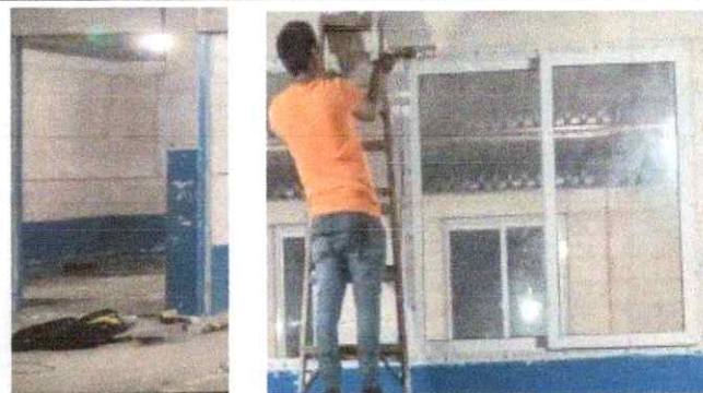
Foto 4: Sustitución de puertas y ventanas
