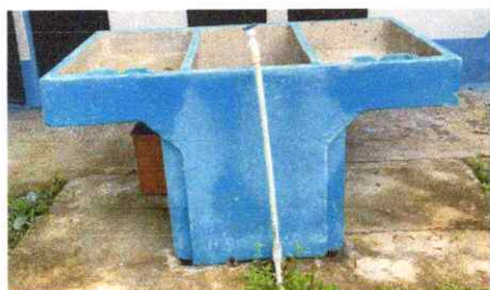
Foto 5: Sustitución de tubería para agua de distribución del pozo y sustitución de pila
