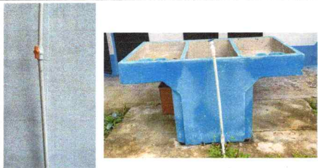
Foto 5: Sustitución de tubería para agua de distribución del pozo y sustitución de pila
