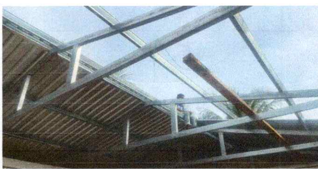
Foto 2: Sustitución de soporte de madera por metal
