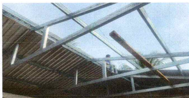
Foto 2: Sustitución de soporte de madera por metal
