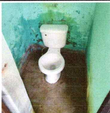
Foto 3: Sustitución de inodoros
