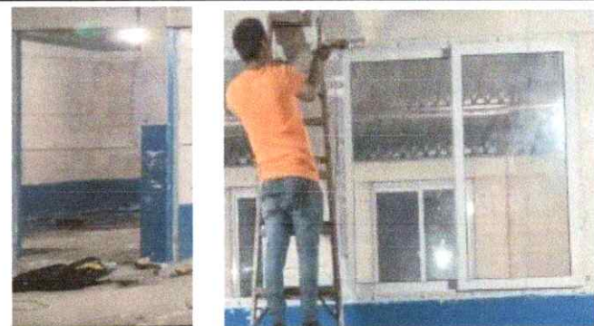
Foto 4: Sustitución de puertas y ventanas
