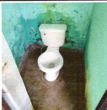
Foto 3: Sustitución de inodoros
