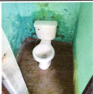
Foto 3: Sustitución de inodoros
