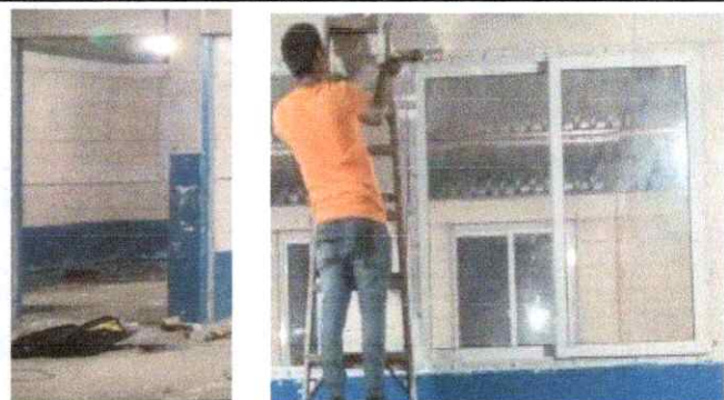
Foto 4: Sustitución de puertas y ventanas
