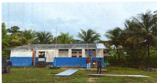
Foto1: Sustitución de láminas en 3 aulas y cocina
